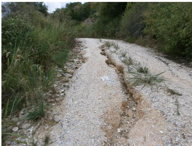
Figura 37. Estado de la vía de acarreo en la cota 200 msnm
