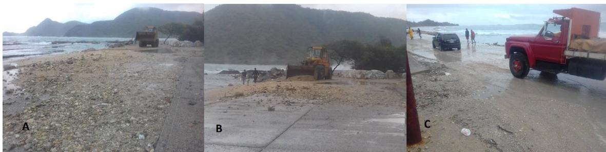
Figura 31. A) Inicio de limpieza con cargador frontal, B) Transcurso de limpieza de la carretera, C) Vehículos transitando en la carretera libre de obstáculos
