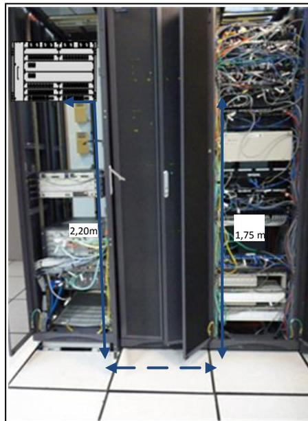
Figura 45 Vista general conexión a SWI-USB-DCN-001 y SWI-USB-DCN-002
