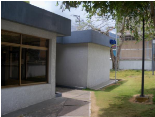
Figura 36. Sede CANTV San Juan de Colón.
