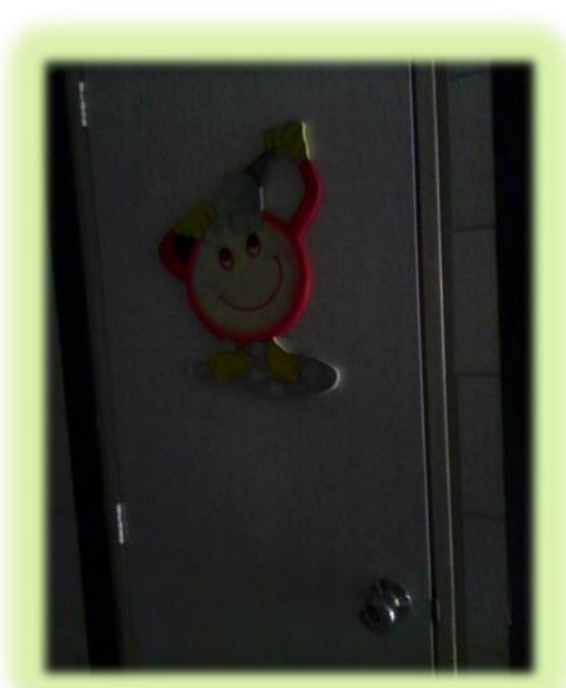
Anexo C-23. Baños.
