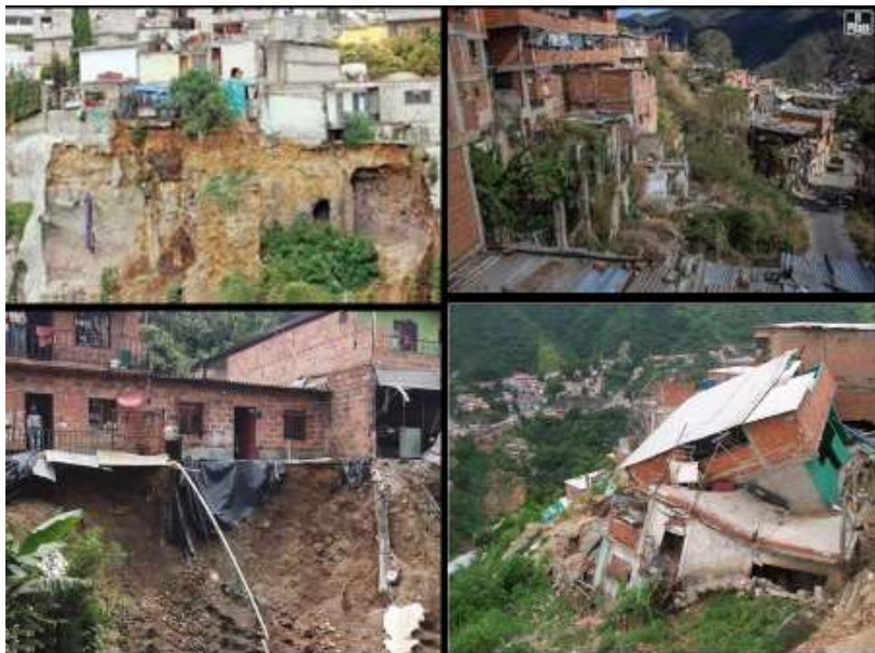
Figura 37. Viviendas en alto riesgo. Elaboración ACS. F/ Google Imágenes.
