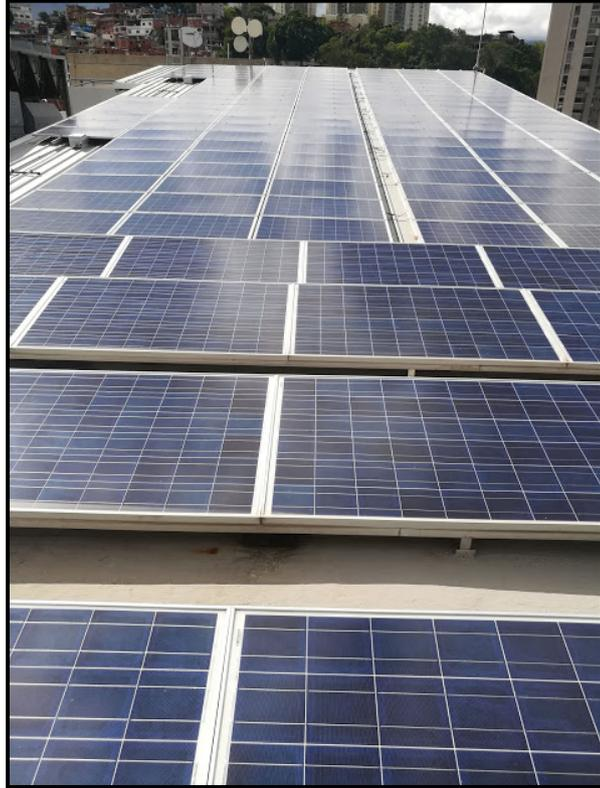
*Figura 21. Paneles Solares con capacidad de 50 kWh de energía generada
