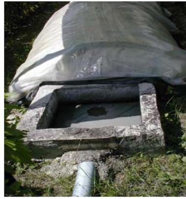
B) Salida del biodigestor
