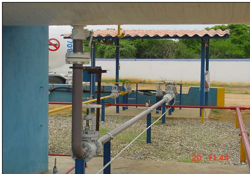
Foto N° 6 Trasiego de camión tanque
