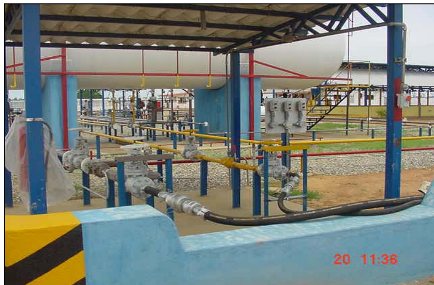
Foto N° 4 Trasiego de camión tanque
