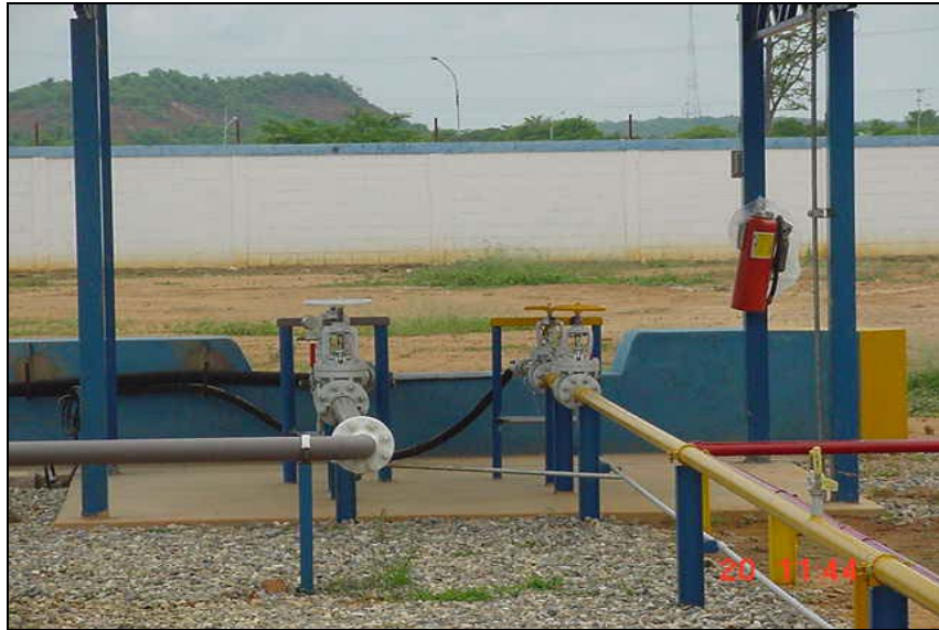
Foto N° 5 Trasiego de camión tanque
