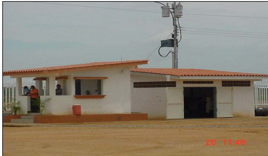
Foto N° 19 Caseta de vigilancia
