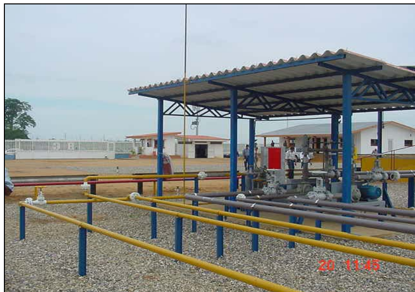
Foto N° 2 Conexión a las líneas de flujo
