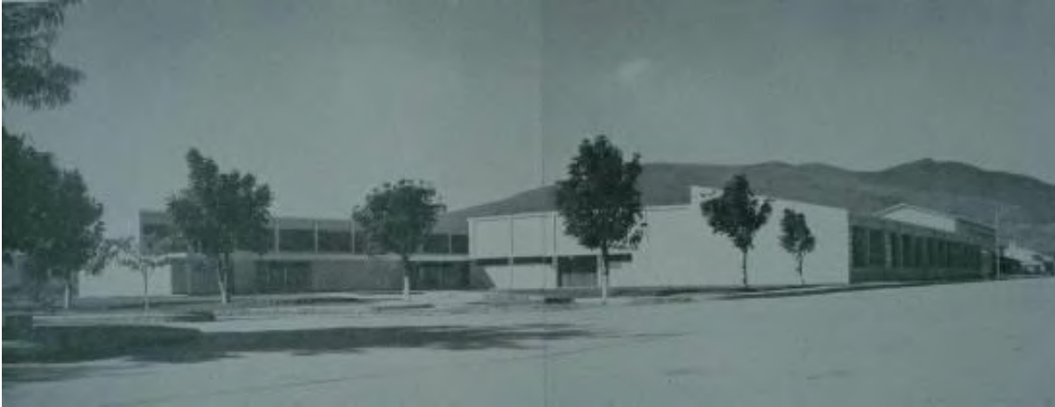
Figura 5. Pabellones de Laborterapia construidos en la Colonia Psiquiátrica de Bárbula e inaugurados junto con el Pabellón de Morgue en diciembre de 1956. Estas edificaciones con su equipo costaron Bs. 1.958.330. Fuente: Venezuela. Ministerio de Sanidad y Asistencia Social (1957). Memoria , p. 288.
