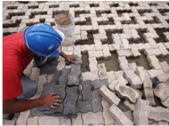
Figura 4. Colocación de adoquines. Bulevar de Sabana Grande.
