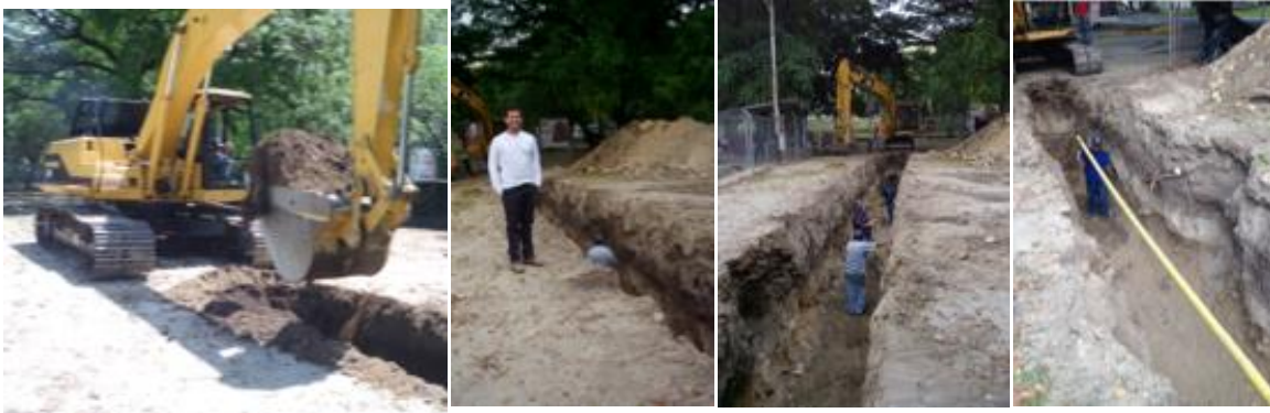
Figura 2. Avances de experimentación, Maracay, estado Aragua Fuente: Reinaldo Ferraro.
