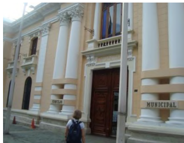
Foto 2 Edificaciones adyacentes a la plaza Fuente: P. Márquez (noviembre de 2013).
