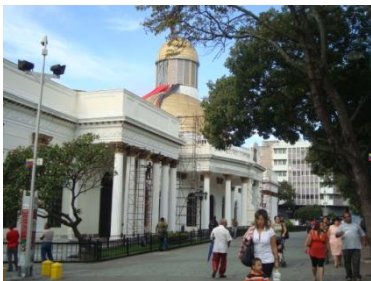
Foto 1 Edificaciones adyacentes a la plaza Fuente: P. Márquez (noviembre de 2013).
