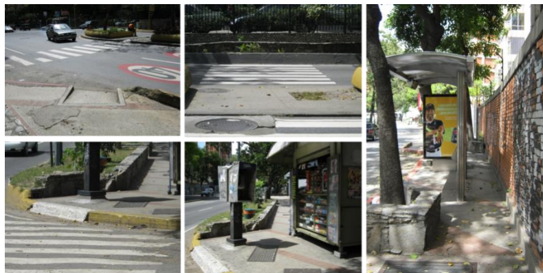
Figura 1. Vistas del espacio del peatón en el bulevar de El Cafetal
