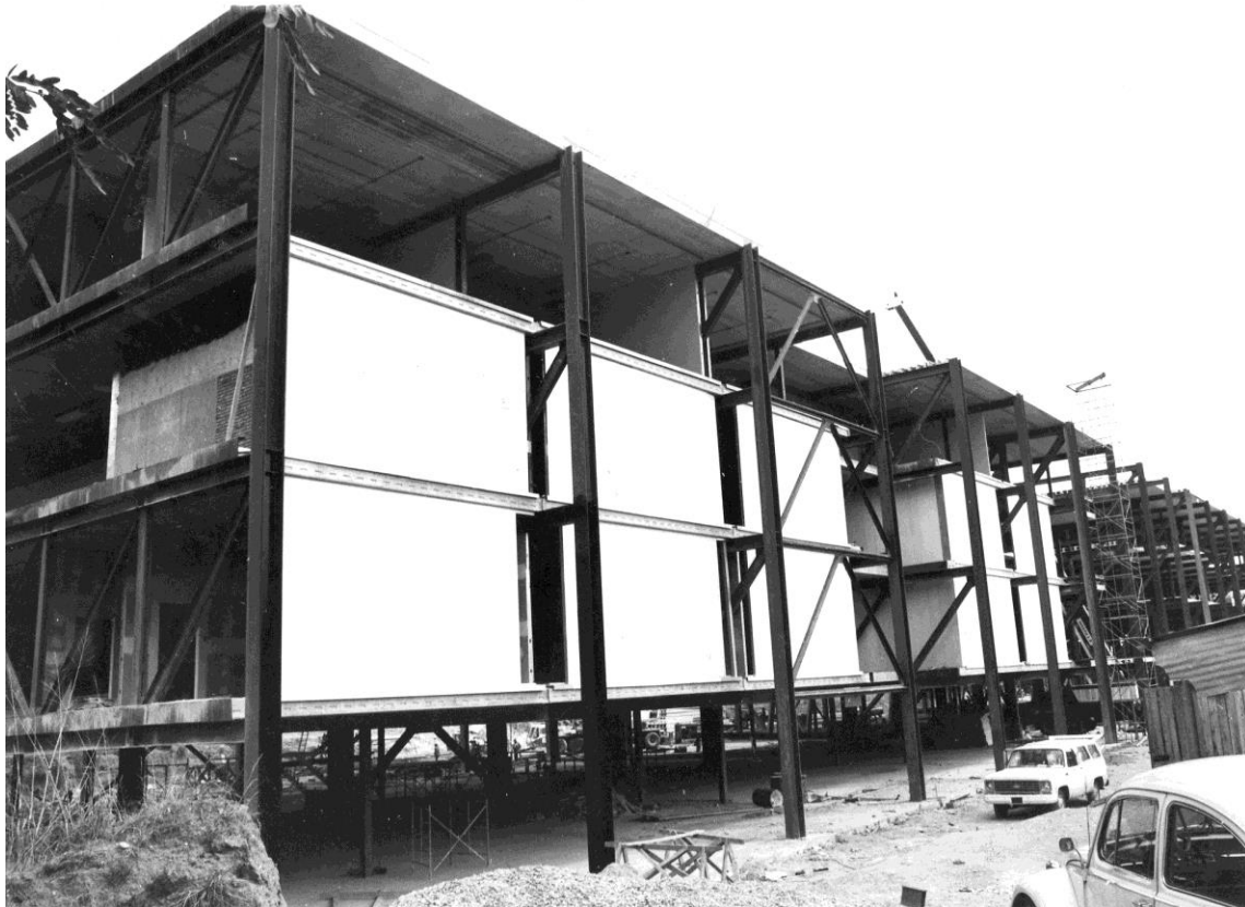
Figura 2. Edificio de Traslado en construcción. Caracas Autor: Calvo, 1976. Archivo Biblioteca Alejandro Calvo, IDEC, FAU, UCV, Caracas, Venezuela.
