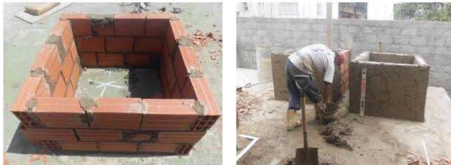
Figura 2. Construcción de los módulos
