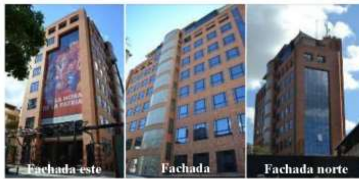
Figura 2. Torre de oficinas, sede Conatel Las Mercedes, Caracas
