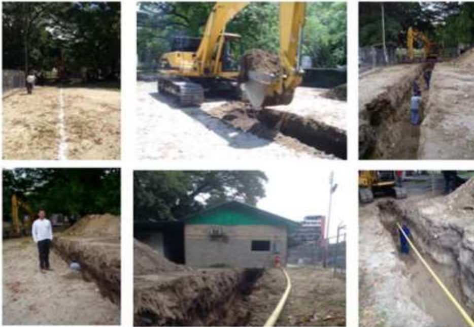
Figura 4. Realización de la zanja y colocación de los tubos. Fuente: Elaboración propia.
