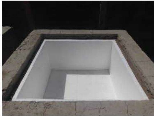
Figura 5. Aislamiento de los módulos con poliestireno expandido
