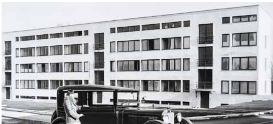
364. Apartamentos en Weissenhofsiedlung. Stuttgart, 1927-1928.
