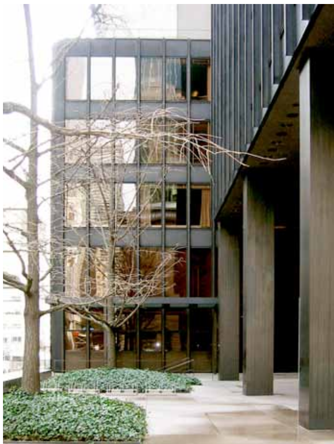
404. Vista del espacio que forman la planta baja de la torre y el cuerpo bajo del fondo.
