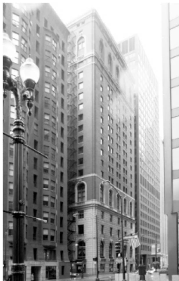
117. Los edificios Monadnock, Union League y Metcalfe en el bulevar Jackson, vistos desde la esquina con Dearborn.
