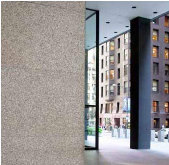
169. La planta baja de la torre de oficinas vista desde el espacio hacia la plaza suroeste. Al fondo el edificio Monadnock.
