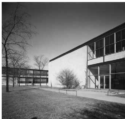
348. Edificios del Instituto Tecnológico de Illinois. Chicago, 1945-1946
