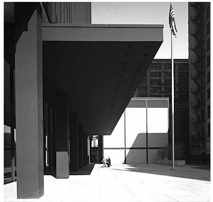
157. La marquesina de entrada a la torre de las cortes desde la plaza al este. Al fondo el edificio de máquinas.
