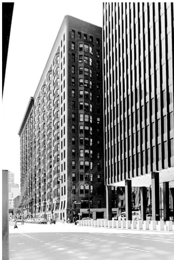
141. La torre de oficinas continúa el plano de fachada del edificio Monadnock en la calle Dearborn.
