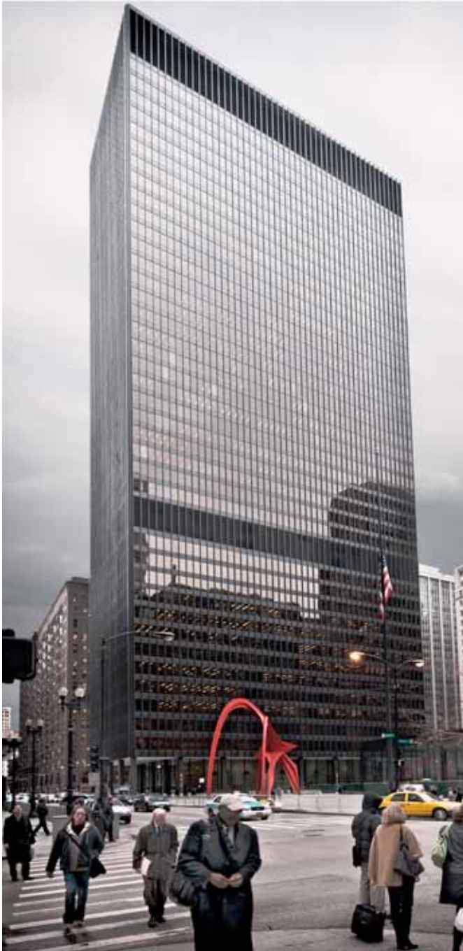
166. Vista de la torre de oficinas desde la esquina entre Adams y Dearborn.
