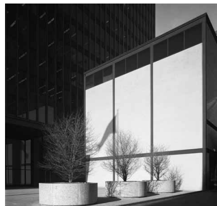
350. Edificio de máquinas del Federal Center de Chicago. 1959-1964.
