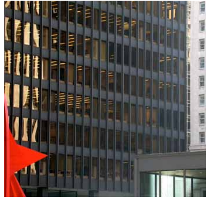
168. La torre de oficinas entre el Flamingo de Alexander Calder y la oficina postal.
