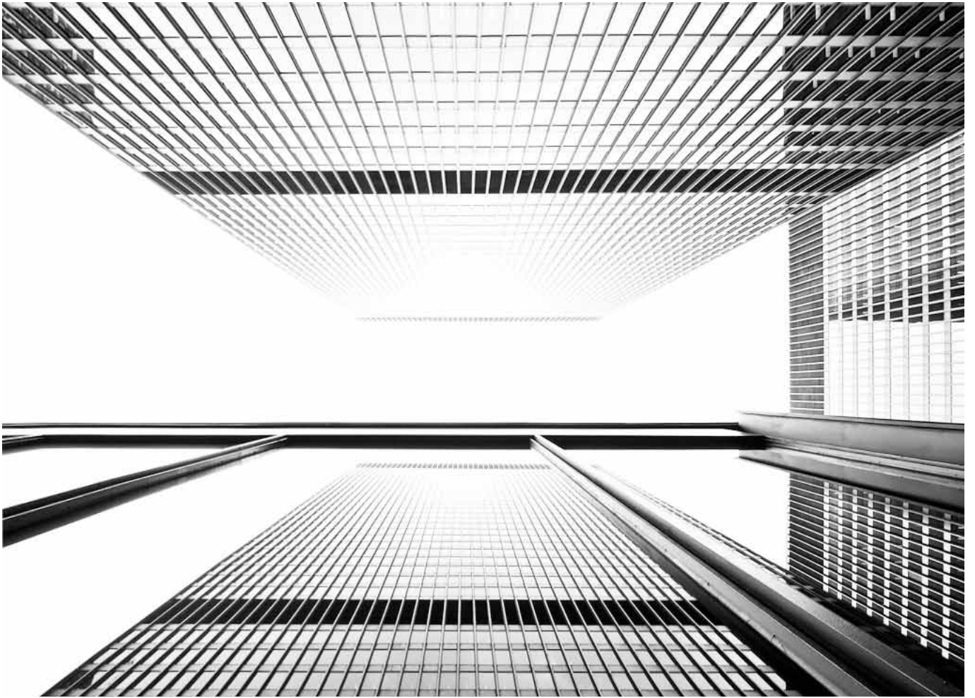
423. El Federal Center de Chicago.
