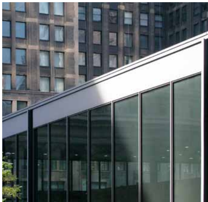
183-186. Vistas de las fachadas del pabellón de la oficina postal.
