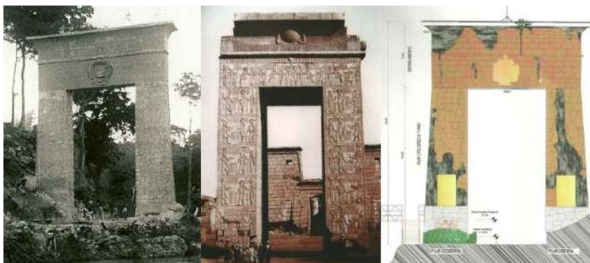
Figura 1: Pórtico Triunfal de La Puerta [Revista Técnica del MOP] Figura 2: Puerta del Templo de Khonsu [Solé, Robert. “Viaje por Egipto”] Figura 3: Deterioros identificados [Diagnóstico, Arq. Miguel Funes]
