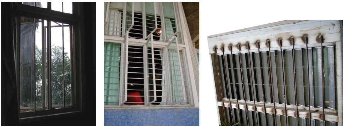
Fig. 21 - Ventanas de abertura vertical que permiten dirigir el flujo de aire.
