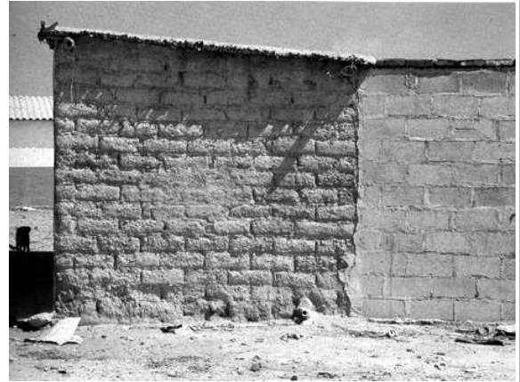
CONSTRUCCIÓN MIXTA ADOBE Y BLOQUES DE CONCRETO
