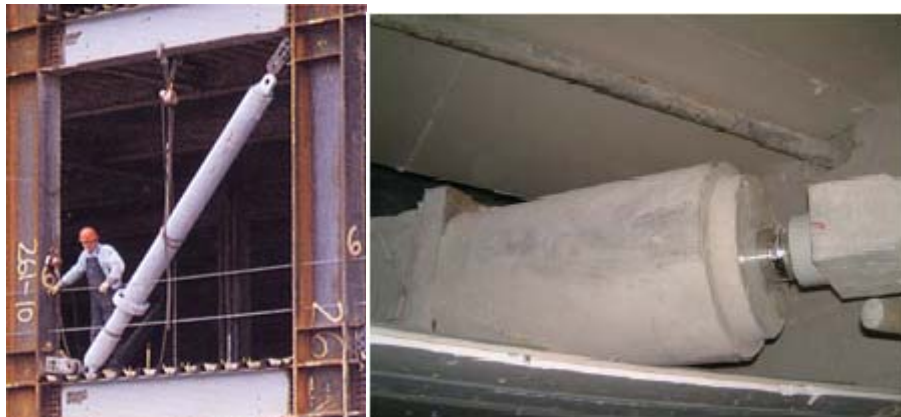
Figura 2.21. Detalle de instalación de amortiguador tipo Taylor.
