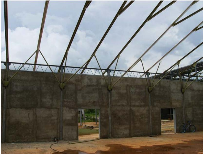
**Figura 2.34.- Nodo tensores correas y vigas transversales techo**
