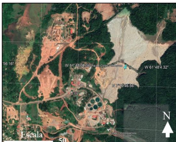
Figura 2. Referencia de ubicación geográfica de la laguna de colas I. Fuente: Google earth modificado por los autores.
