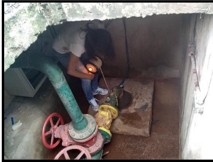
Fig. 17: Medición del nivel piezométrico en el pozo UCV-002
