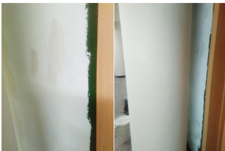
Fotografías tomadas el 25 de Octubre de 2021. La pintura original de paredes de la VMB-I adyacentes a la entrada de los baños (parte del proyecto VMB-I). Originalmente verde. Cubierta con pintura blanca.
