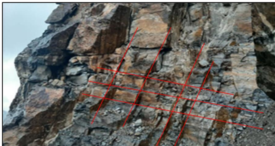
Figura 5. Sistema paralelo de diaclasa presentes en el macizo rocoso.
