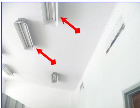
Imagen 28. Material propio. Fernández, H. (2019). Lámparas con bombillos fluorescentes sin protectores UV.
