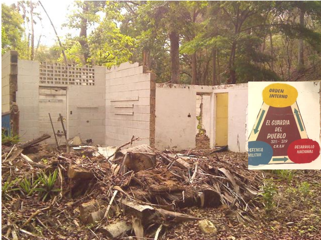
Imagen 53. Material propio. Comando de la GNB destruido por el vandalismo dentro del Jardín Botánico UCV. Se propone recuperar este espacio para instalar un Centro de Comando, Control y Telecomunicaciones VEN 911.
