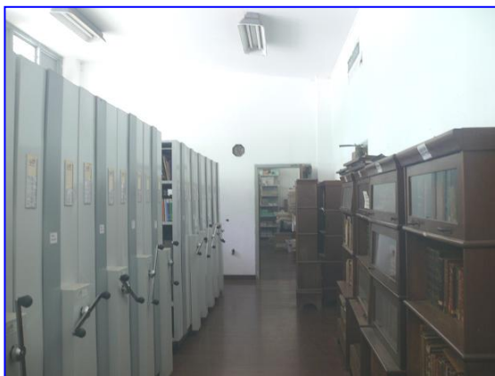
Imagen 24. Material propio. Fernández, H. (2019). Paredes y techo de concreto armado con piso de madera.
