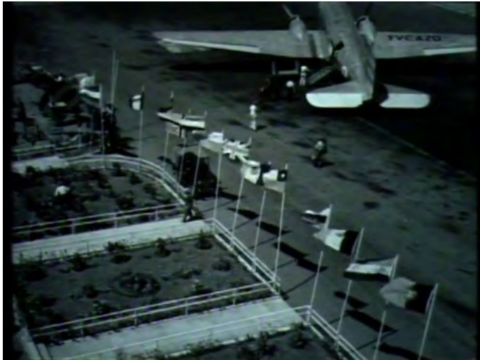
Figura 9. El aeropuerto internacional de Maiquetía.
