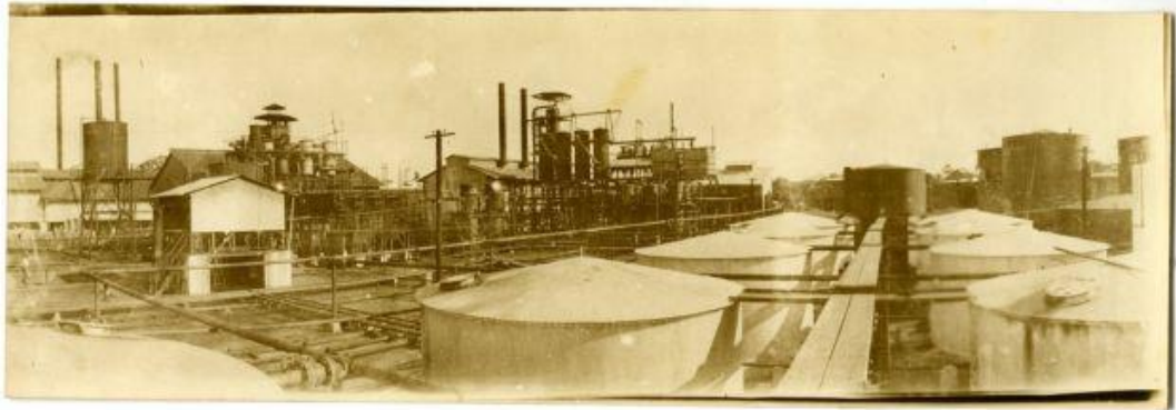
Figura 15. Instalaciones industriales en un campo petrolero (circa 1920-1930; Fondo Visual AFU)
