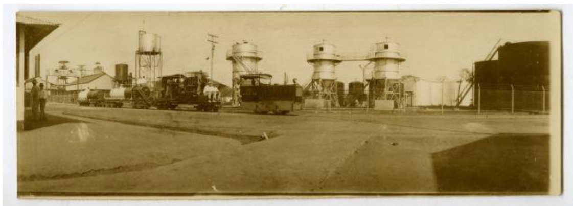
Figura 14. Instalaciones industriales en un campo petrolero ( circa 1920-1930; Fondo Visual AFU)
