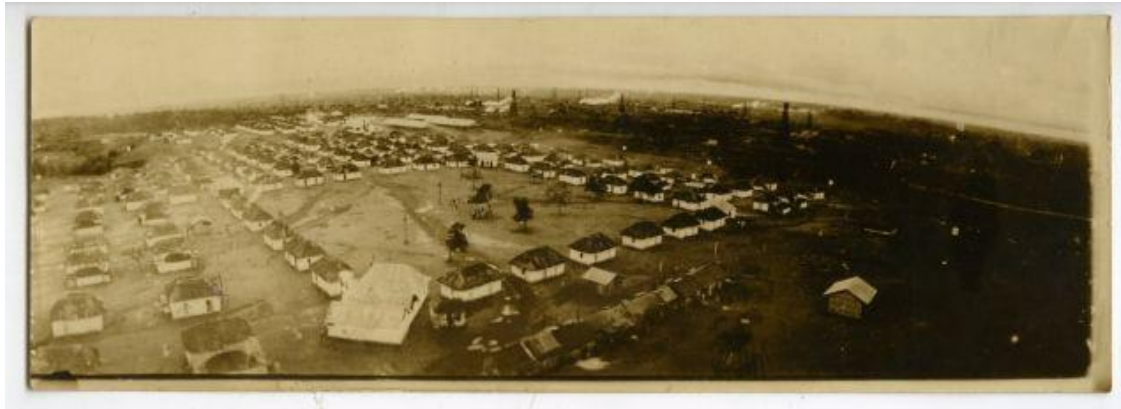
Figura 13. Vista aérea de campamento petrolero residencial ( circa 1920-1930; Fondo Visual AFU)
