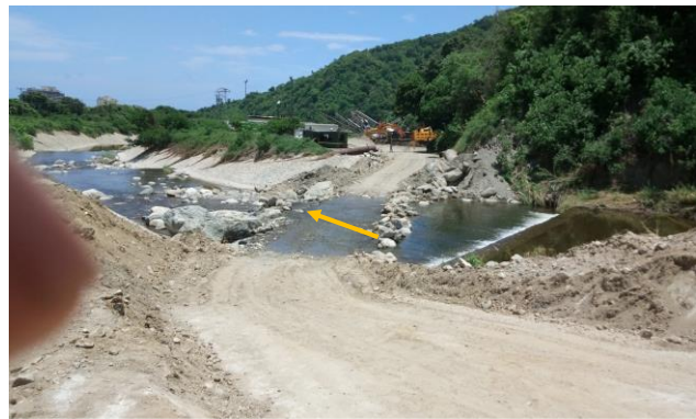
Figura 23. Cruce de carretera sobre canalización del río Camurí Grande, aguas arriba de la población. Vista del terraplén y batería de alcantarillas construido por la empresa arenera para el paso de camiones. Izquierda: foto tomada el año 2011 mostrando el terraplén recién construido (Foto de J.I. Sanabria); Derecha: foto tomada por el autor el 12/09/21, mostrando la destrucción del terraplén por los flujos de 28/08/21.
