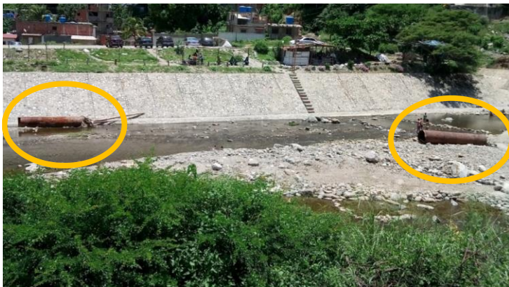
Figura 24. Restos de los tubos depositados aguas abajo en el lecho de la canalización del río Camurí Grande. El diámetro de los tubos es de 1,10 m (Foto tomada el 12/09/21).
