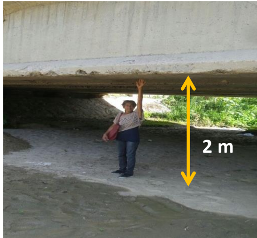
Figura 27. Vistas del puente en la Av. La Playa sobre el río San Julián. Izquierda: la luz del puente se había reducido el año 2016 a unos 2 m debido a la sedimentación del cauce, en donde la altura del canal era de 4 m. Derecha: trabajo de maquinarias removiendo la terraza sedimentaria de 2 m de espesor debajo del puente (Fotos de Mariela Gómez).
