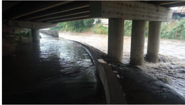
Figura 30. Desbordes del río Guaire con la tormenta del 28/07/21. Izquierda: desbordes en el Distribuidor Lebrúm de la Autopista en Petare; Derecha: desbordes en el Barrio La Línea den Petare. Ambos desbordes son atribuidos a la sedimentación que presenta la canalización del Guaire en este sector.
