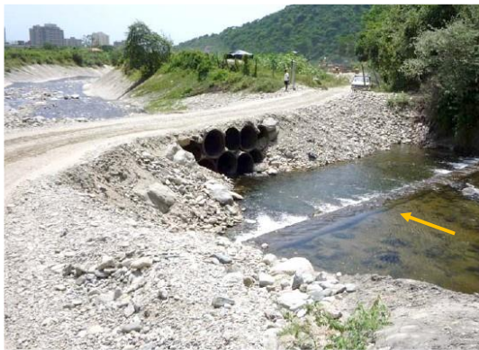
Figura 23. Cruce de carretera sobre canalización del río Camurí Grande, aguas arriba de la población. Vista del terraplén y batería de alcantarillas construido por la empresa arenera para el paso de camiones. Izquierda: foto tomada el año 2011 mostrando el terraplén recién construido (Foto de J.I. Sanabria); Derecha: foto tomada por el autor el 12/09/21, mostrando la destrucción del terraplén por los flujos de 28/08/21.
