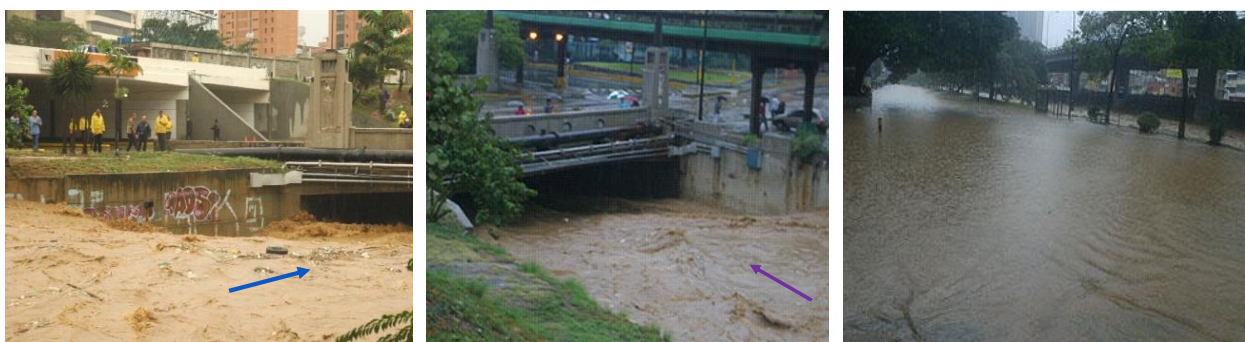
Figura 19. Efectos de la creciente del río Guaire en febrero del 2005. a) Vista de la depresión del flujo en el puente y aumento de los niveles (remanso) hacia aguas arriba (fotos izquierda y centro). b) Inundación en Bello Monte, frente a la Alcaldía de Baruta, en febrero del 2005, debido a los efectos de remanso originados por el puente Las Mercedes (Fotos extraídas de Internet).
