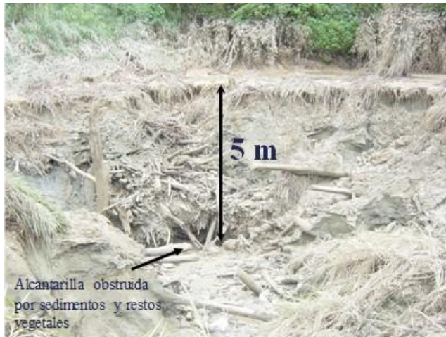
Figura 13. Izquierda: vista de la alcantarilla obstruida por restos vegetales y sedimentos, cuya profundidad de sedimentación era de aproximadamente 5 m sobre el tope del conducto. Derecha: marca sobre un árbol de la altura que alcanzaron las aguas (5 m sobre el nivel del terreno), en la laguna que se creó debido a la obstrucción.
