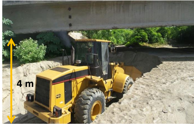
Figura 27. Vistas del puente en la Av. La Playa sobre el río San Julián. Izquierda: la luz del puente se había reducido el año 2016 a unos 2 m debido a la sedimentación del cauce, en donde la altura del canal era de 4 m. Derecha: trabajo de maquinarias removiendo la terraza sedimentaria de 2 m de espesor debajo del puente (Fotos de Mariela Gómez).
