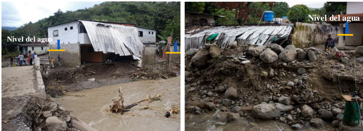
Figura 4. Marcas de agua dejadas por flujos de crecientes que escurrieron por la planicie inundable, ocupada por viviendas. Izquierda: río Zorquera el 11/11/20, en el municipio de Zorca, San Cristóbal, Estado Táchira. Derecha: río Manguito el 17/11/20 en el barrio El Pinal, en El Limón, Estado Aragua (fotografías extraída de Internet).
