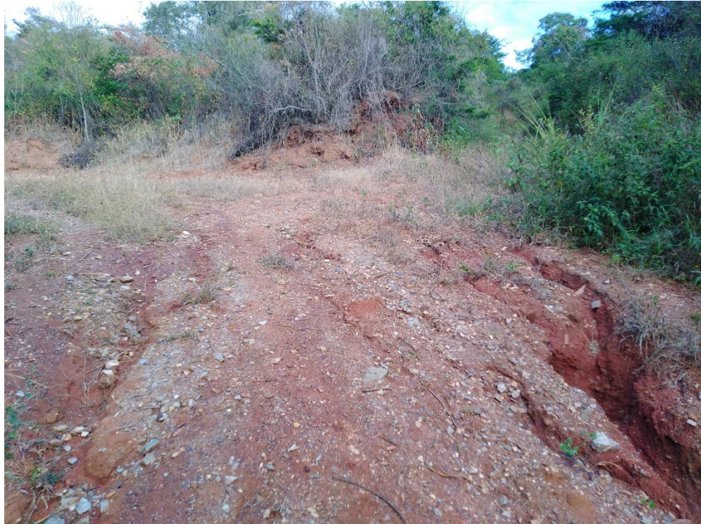
Figura N°45: Cárcavas producto de precipitaciones anteriores.
