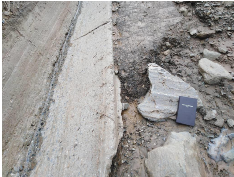
Figura N°53: Canales preexistentes en vialidad de Mina 2, Canteras de Distrito Capital. Fuente: Elaboracion Propia.
