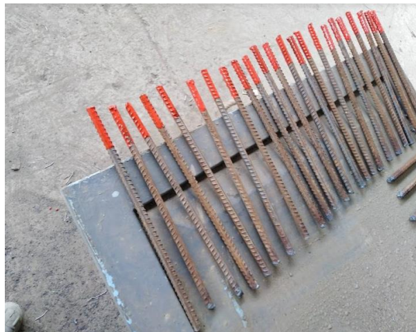
Figura N°24: Clavos (Vigas) para la instalación de la PEC.
