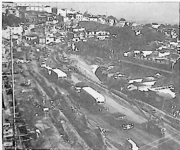
Construcción de la Avenida Sucre. Fotografía de Luis Felipe Toro
