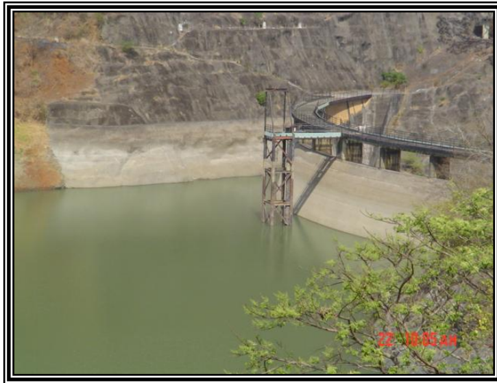
Foto N° 4: Presa Ocumarito en donde se visualiza el nivel de agua presente.
