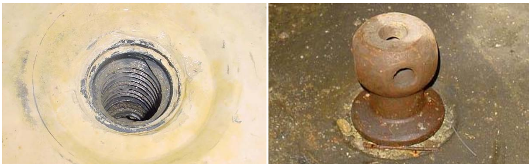
Figura 106. Izquierda: Inserto dentro del segmento. Derecha: Perno de sujeción colocado en el segmento.
