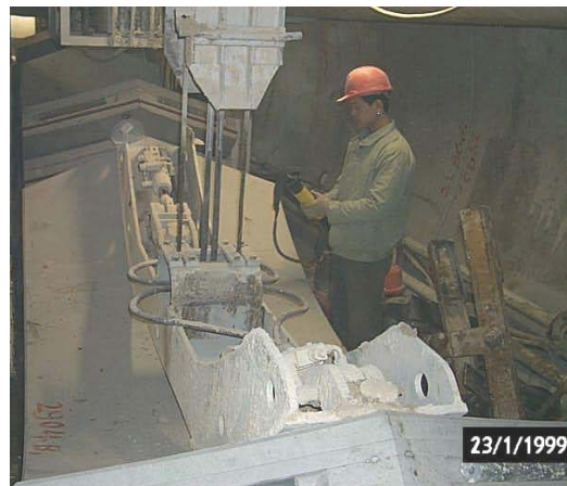
Figura 3. Sistema de sujeción en una máquina tuneladora Robbins.
