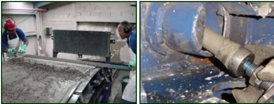
Figura 98. Izquierda: Frisado de la superficie externa del segmento. Derecha: Retiro de los bulones curvos de los moldes (Fuente: Cavalli).
