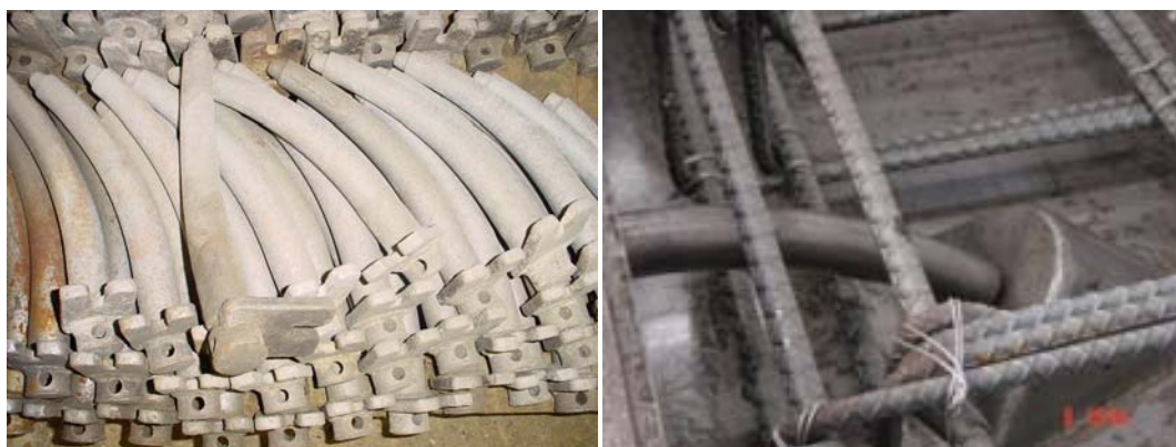
Figura 95. Izquierda: Bulones de los moldes. Fuente: Autores. Derecha: Bulones y armadura colocados en el molde (Fuente: Cavalli).
