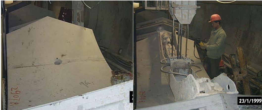
Figura 109. Izquierda: Segmentos con aberturas en su cara interna. Derecha: Sujeción del segmento con el sistema de la empresa Robbins (Fuente: Escobar).
