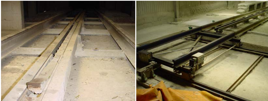
Figura 100. Izquierda: Rieles de la línea de producción con detalle de la pestaña de empuje. Derecha: Sistema de cambio de vías a rieles paralelos.
