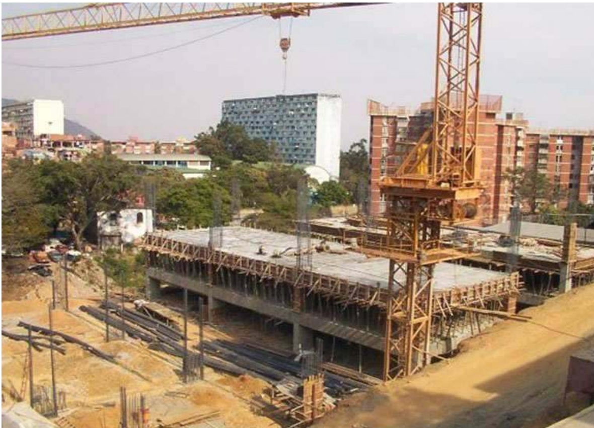
Arriba: la comunidad de Asocica reunida en el terreno donde se edificarían luego los edificios “Nuevo Catuche”. Estos terrenos fueron adquiridos por el Consorcio Social Catuche gracias al aporte del pueblo alemán. Abajo: adelanto en la construcción de estos edificios, 23/03/01 Cortesía: Consorcio Social Catuche/César Martín
