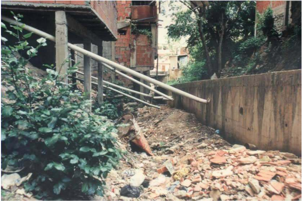
Algunas obras hechas en Catuche antes de 1999. Arriba, colectores residenciales de aguas negras y abajo infraestructura sanitaria para separación de aguas negras de aguas de lluvia en la quebrada Catuche.
