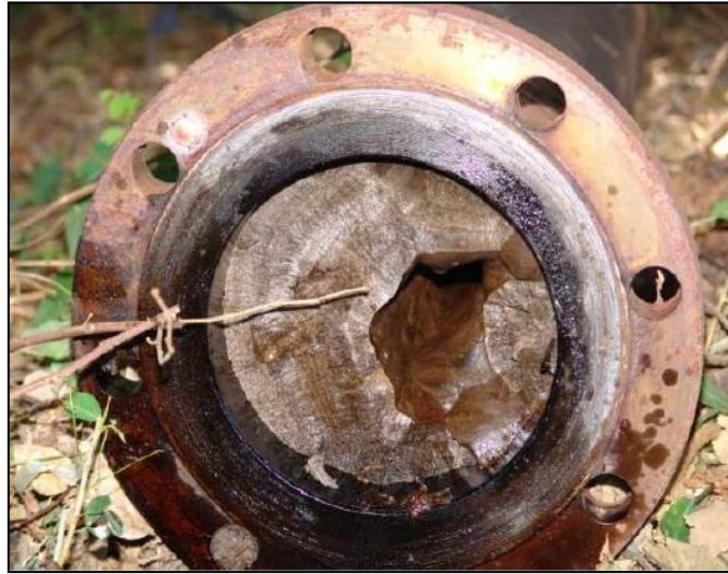
Figura 2.2. Pozo del Estado Barinas afectado por incrustaciones de \text{CaCO}_3
