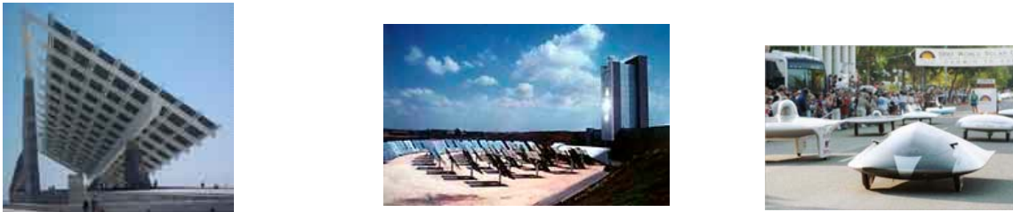
Figura. 2.6 Paneles y espejos solares
