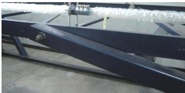
Figura 30. Apoyo “B” luego de su construcción
