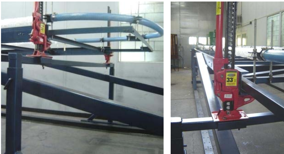
Figura 46. Sistema de gatos mecánicos para levantamiento inicial
