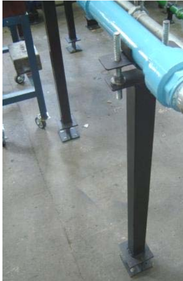
Figura 43. Bases para la tubería de suministro de aire
