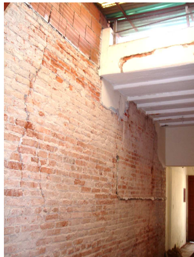
Imagen N° 58: Muro portante de vivienda en los Pasajes. 2008. Foto: del autor.
