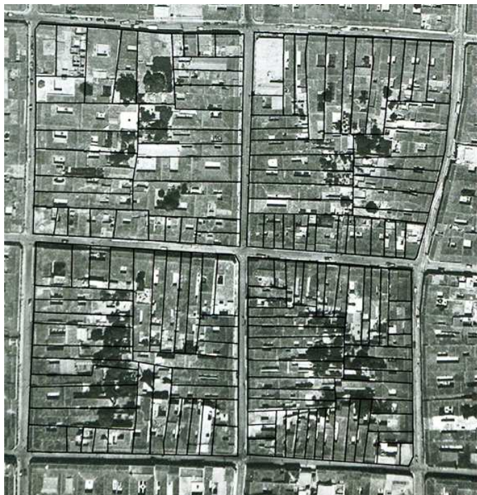
Imagen N° 1: Parcelamiento fragmentado, Parroquia Santa Rosalía. 1936.
