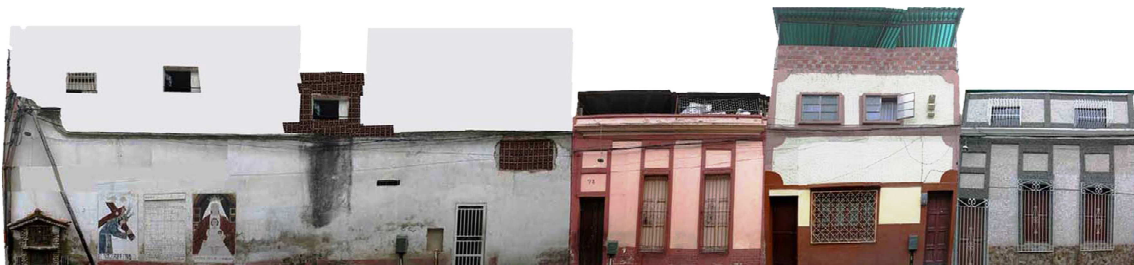
Imagen N° 38: Muro lateral de vivienda esquinera en el Pasaje 4 con Av. Ruiz Pineda. 2006.
