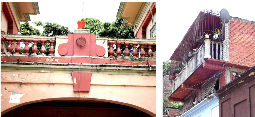
Imagen N° 60: Elementos prefabricados en edificaciones de San Agustín del Sur. 2008. Fotos: del autor.
