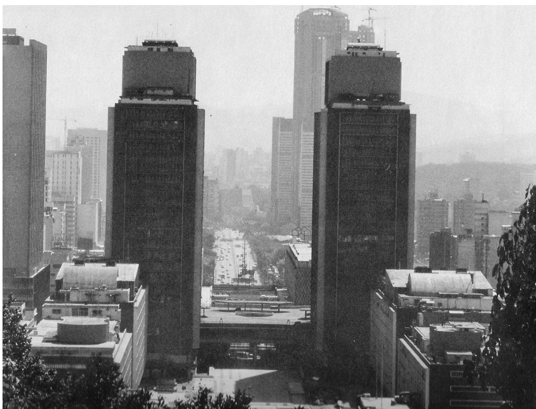
Imagen N° 23: Torres del Centro Simón Bolívar y de Parque Central al fondo. S/F.
