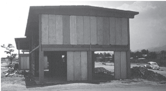
Foto 1 Sistema C4 de Vivienda Venezolana. Columnas, vigas y losas para viviendas unifamiliares de 1 y 2 pisos. Foto: archivo IDEC.
