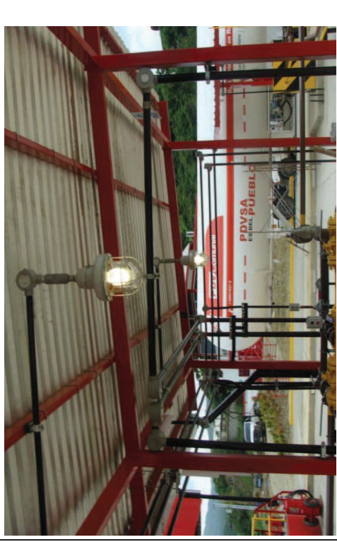
Foto IV.14. Electricidad en Áreas Clasificadas, lámpara a prueba de explosión
