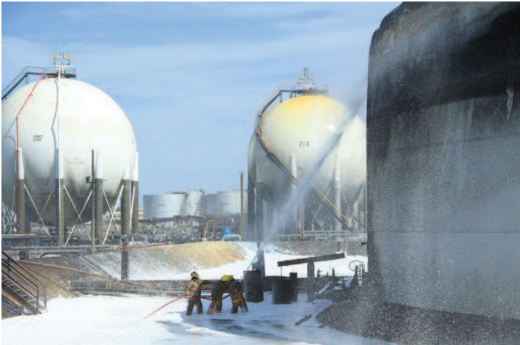
Foto 7. Proceso de extinción del fuego y refrigeración de los tanques
