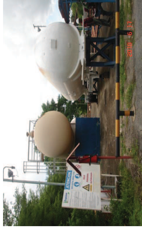
Foto IV.21. Tanque de almacenamiento de GLP en mal estado, PH vencida, pintura deteriorada, sin rociadores.
