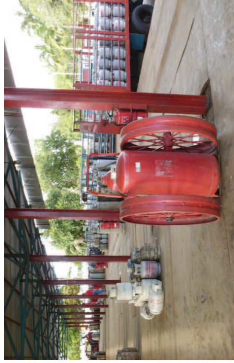
Foto IV.9. Plataforma de Llenado de cilindros de GLP sin defensa contra impacto vehicular y en mal estado fisico
