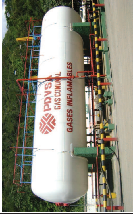
Foto IV.22. Tanque estacionario en buenas condiciones con sistema de rociadores y avisos preventivos
