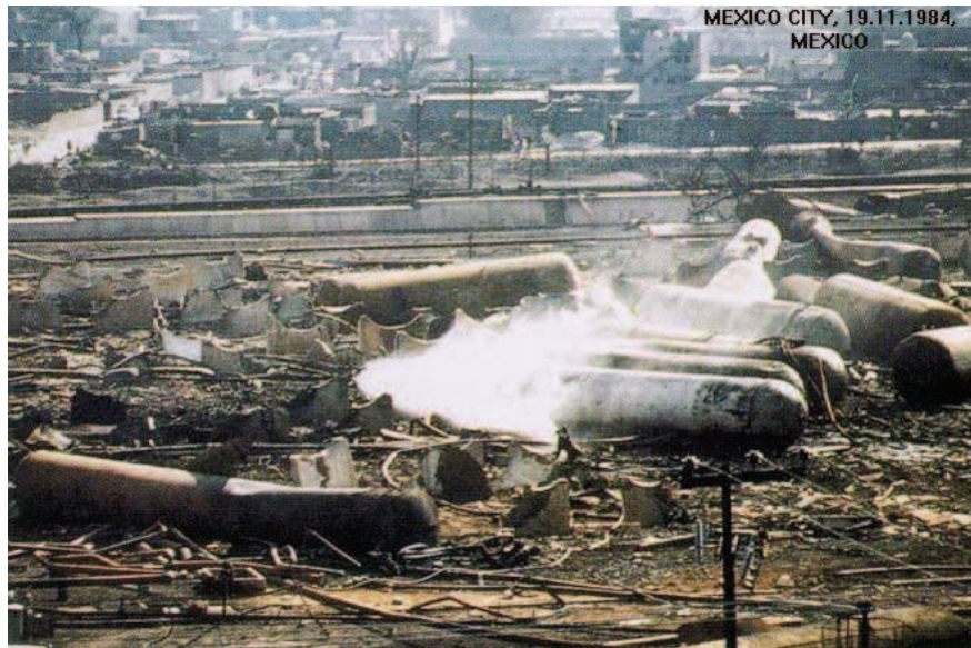
Foto 11. Área destruida por la explosión e incendio. Esferas de GLP estallaron (BLEVE y efecto dominó)
