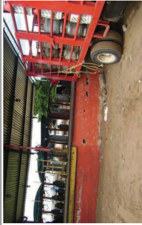
Foto IV.9. Plataforma de Llenado de cilindros de GLP sin defensa contra impacto vehicular y en mal estado fisico
