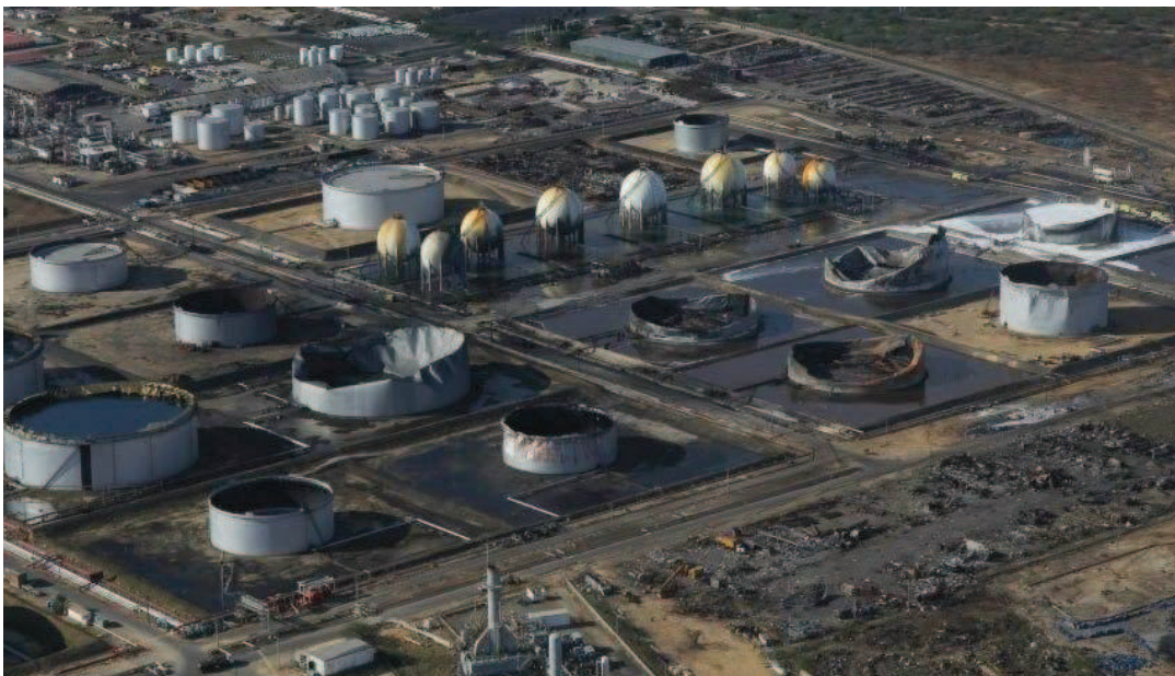
Foto 8. Estado del área afectada por el fuego y la explosión, luego de apagar el incendio.
