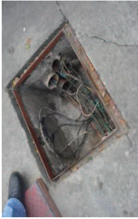
Foto IV.13. Electricidad en Áreas Clasificadas, sin sellos a prueba de explosión
