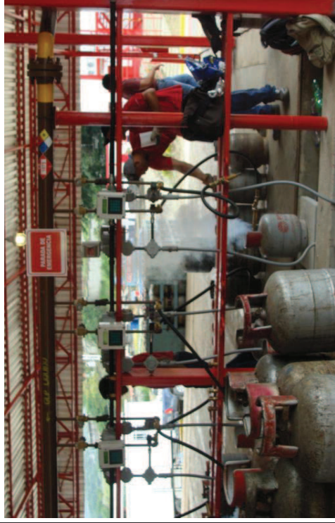
Foto IV.10. Plataforma de llenado en buen estado fisico y con defensa contra impacto vehicular
