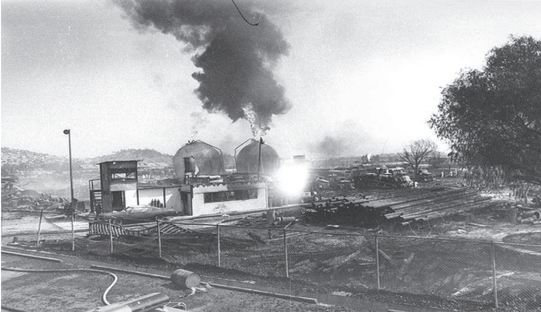
Foto 9. Esferas de GLP afectadas por la explosión
