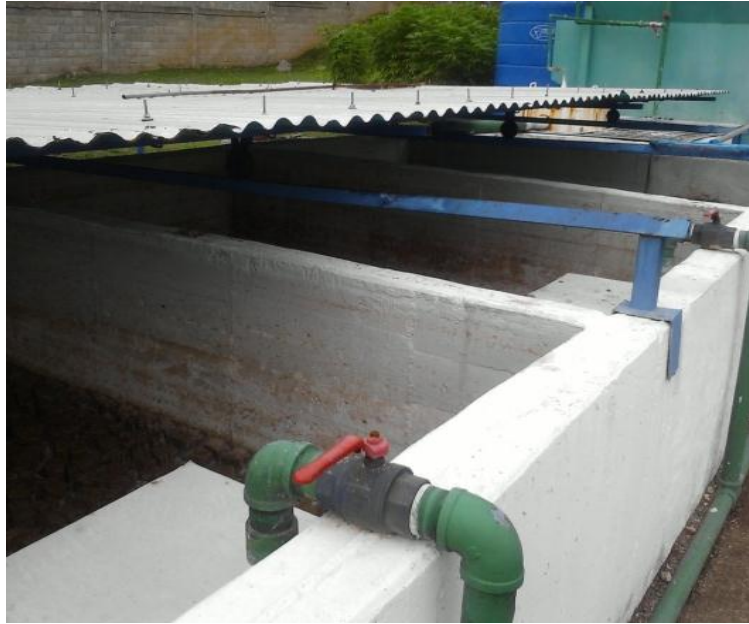
Figura N° 17: Lechos de Secado de la PTARI
