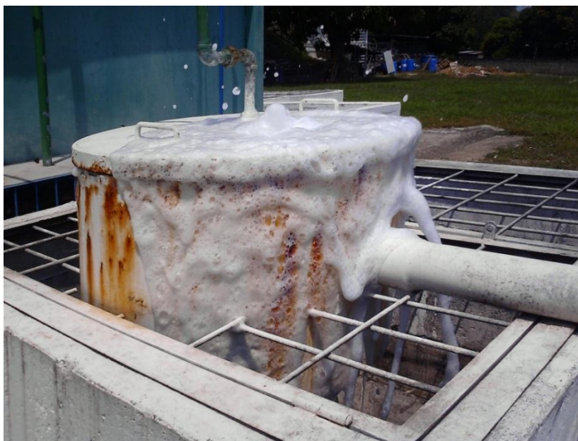
Figura N° 31: Derrame de espuma en el Separador de Espuma
