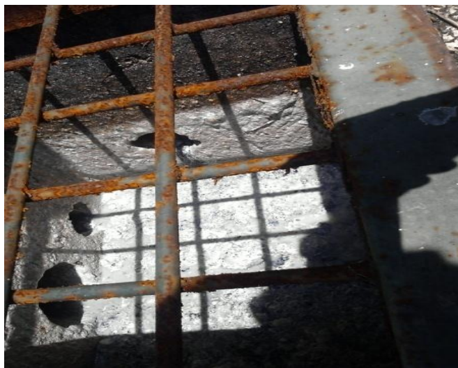
Figura N° 40: Tanquilla de drenaje de los Lechos de Secado, con el nivel de líquido por debajo de las salidas de las tuberías que conectan con dichos lechos
