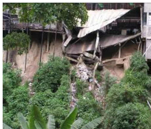
Figura 18. Caída de vivienda por socavación basal.
