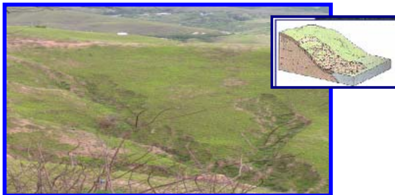
Figura 40. Deslizamiento translacional (Azimut 120°- Altos de Pipe).
