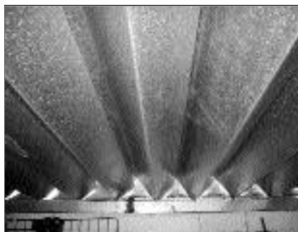
Figura 15 Techo de láminas plegadas, vista inferior.
