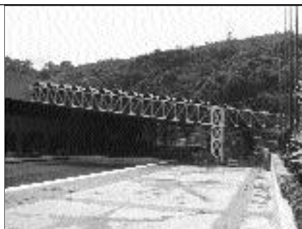
Figura 18 Vista general lateral.
