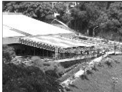
Figura 19 Vista general arriba.
