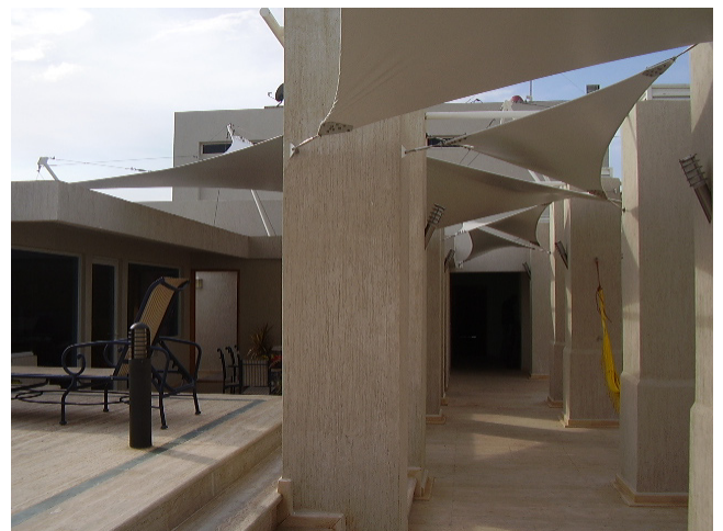
Fig.55 Vista del pasillo
