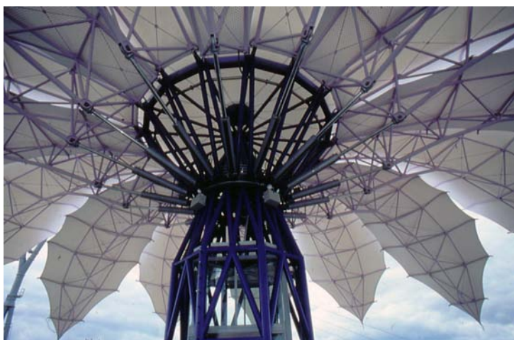
Fig.39 Mecanismos de despliegue
