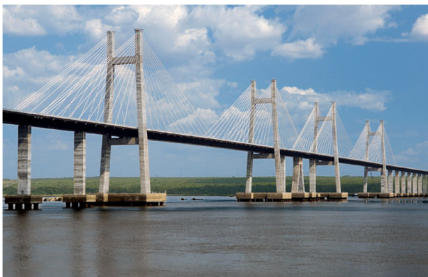
Fig.11 Segundo Puente sobre el Orinoco (Orinokia)
