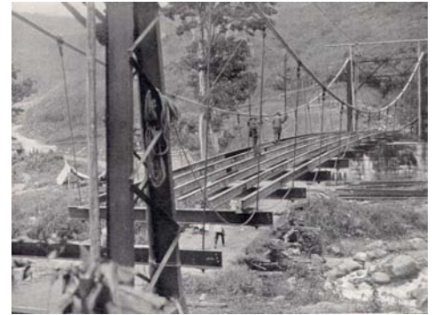
Fig.1 Puente quebrada Cordero
