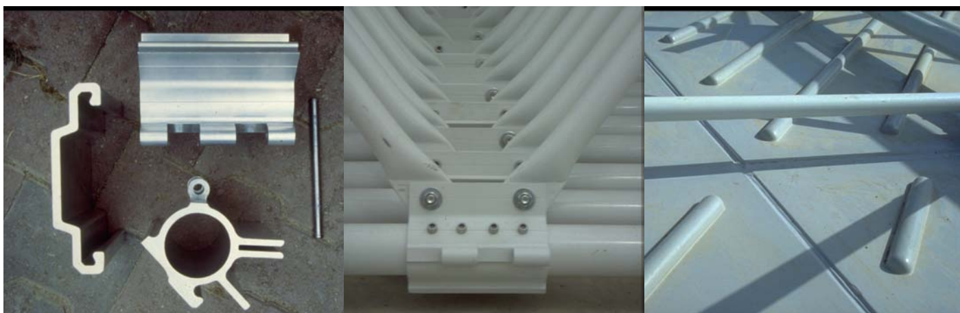
Fig.31 Piezas que conforman el nodo. Fig.32 Ensamblaje de las cerchas. Fig.33 Paneles de cerramiento.
