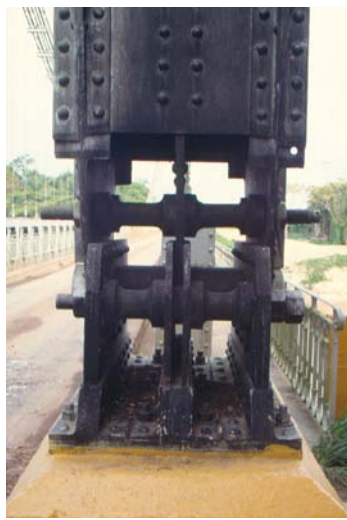
Fig.7 Anclaje de la torre
