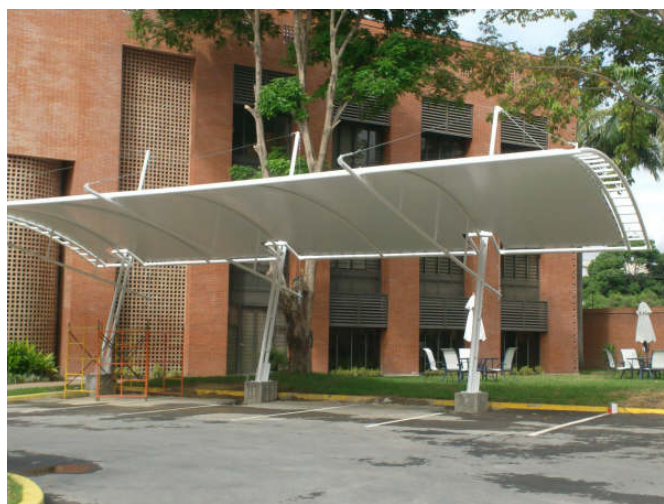
Fig.57 Vista cubierta estacionamiento
