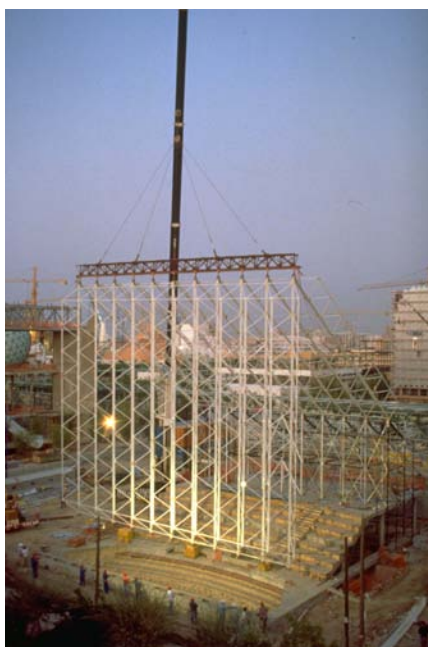
Fig.35 Colocacion en su posicion final.
