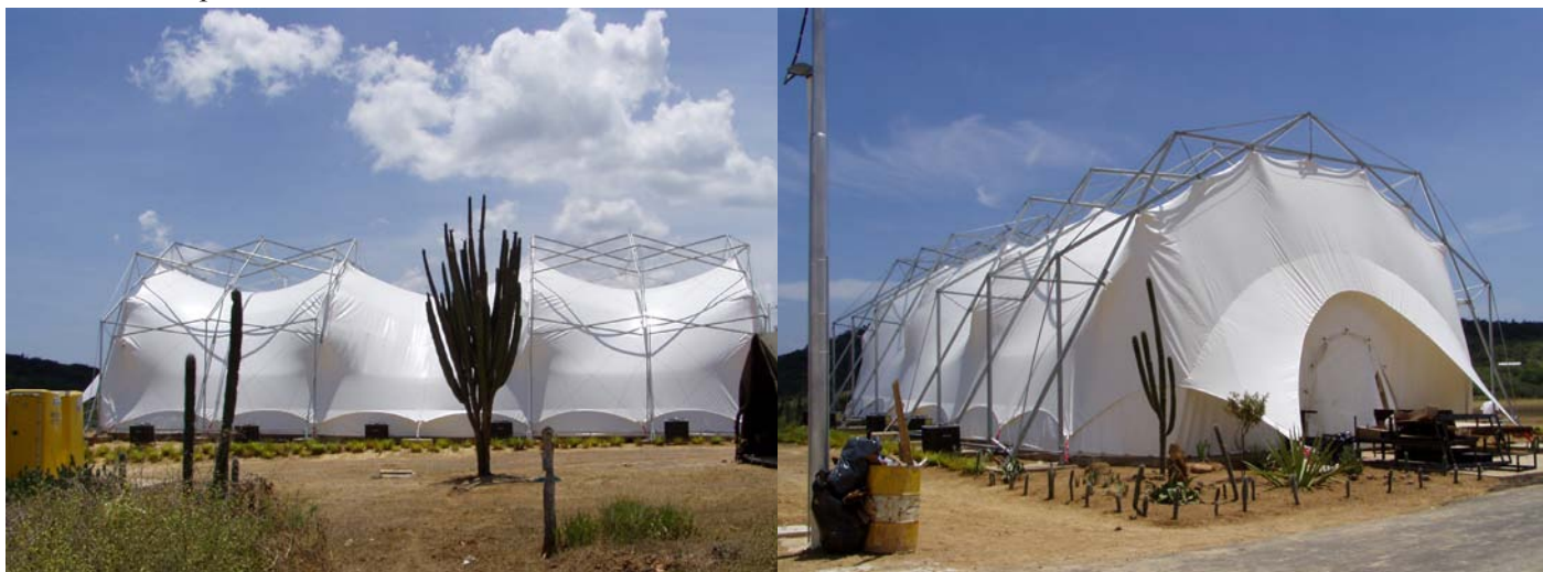
Fig.22 Estructura Transformable Estran 1 aplicacion como pabellon itinerante.
