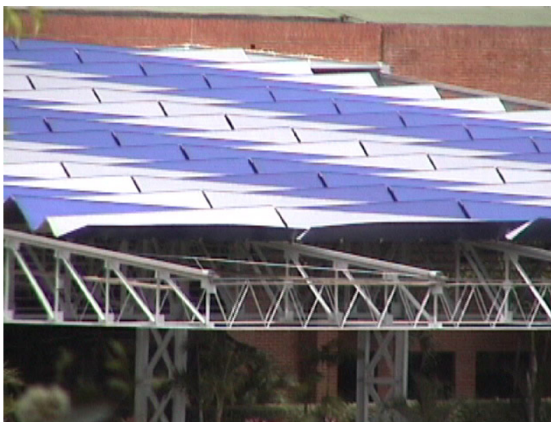
Fig.24 Cubierta transformable de laminas metalicas delgadas
