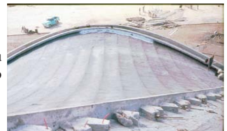
Fig.20 Anclajes de los cables
