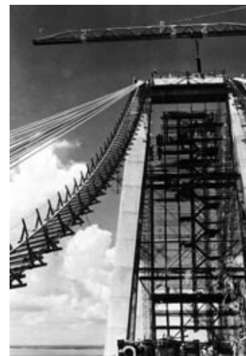
Fig.8 Colocacion de cables (lago de Maracaibo)
