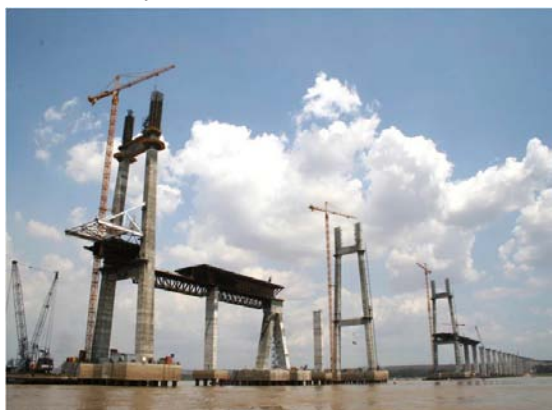
Fig.12 Puente Orinokia construcción de torres
