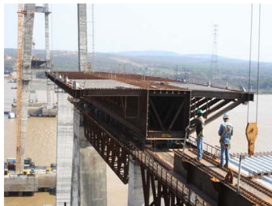
Fig.13 Emsamblaje del tablero seccion central
