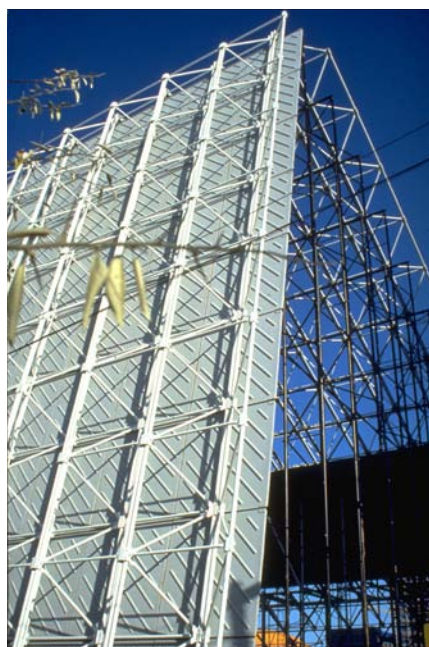
Fig.36 Fijacion de los paneles
