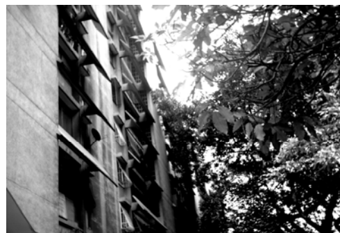
Las ventanas del edificio “Los Aleros” muestra un sistema de protección ambiental con grandes aleros de concreto. Figura 5: Fotografía tomada por el autor.
