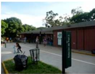
F1. Cafetín y sanitarios
