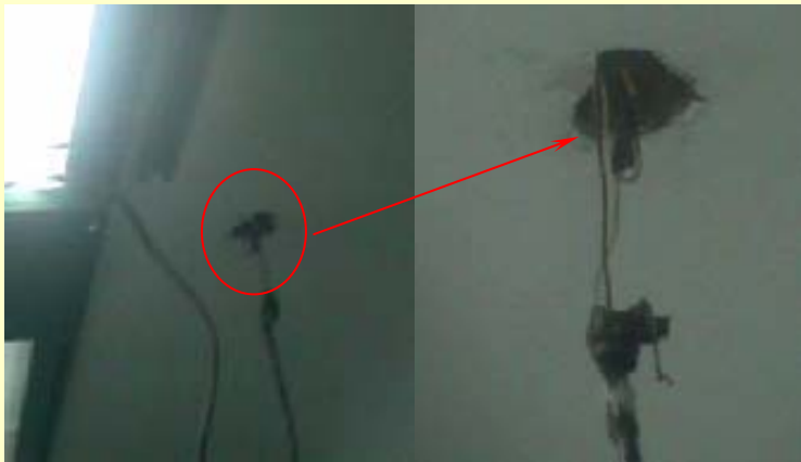
Cable de la lámpara cialítica colgando.
