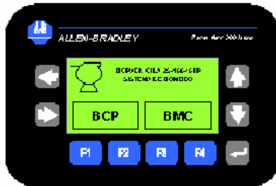
Pantalla Sistema de Bombeo
