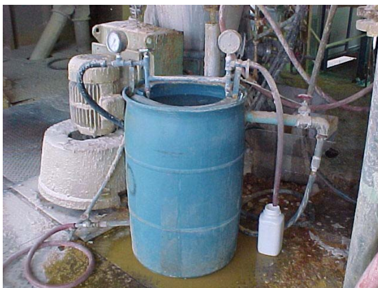
Figura N° 5.15 Condensador utilizado para efectuar las mediciones del flujo de vapor
