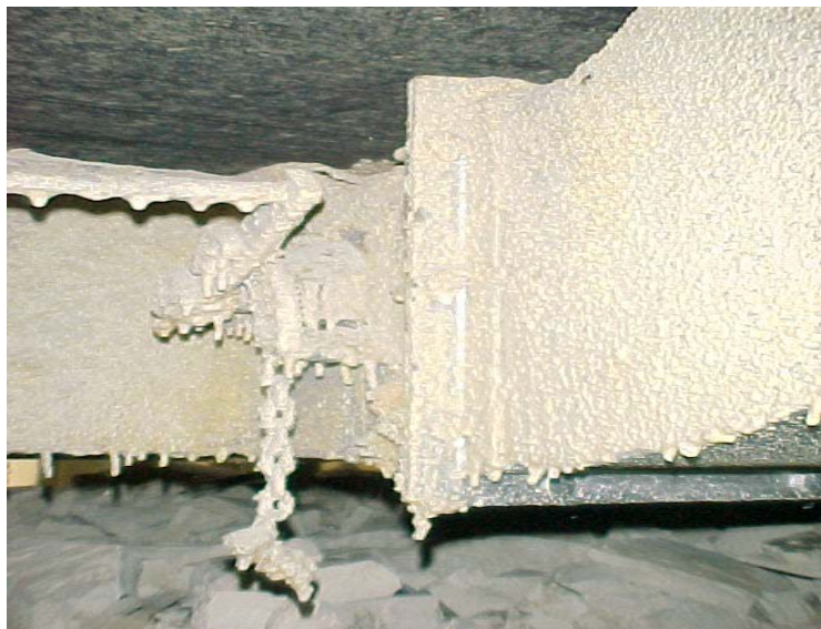
Figura N° 5.10 Damper obstruido
