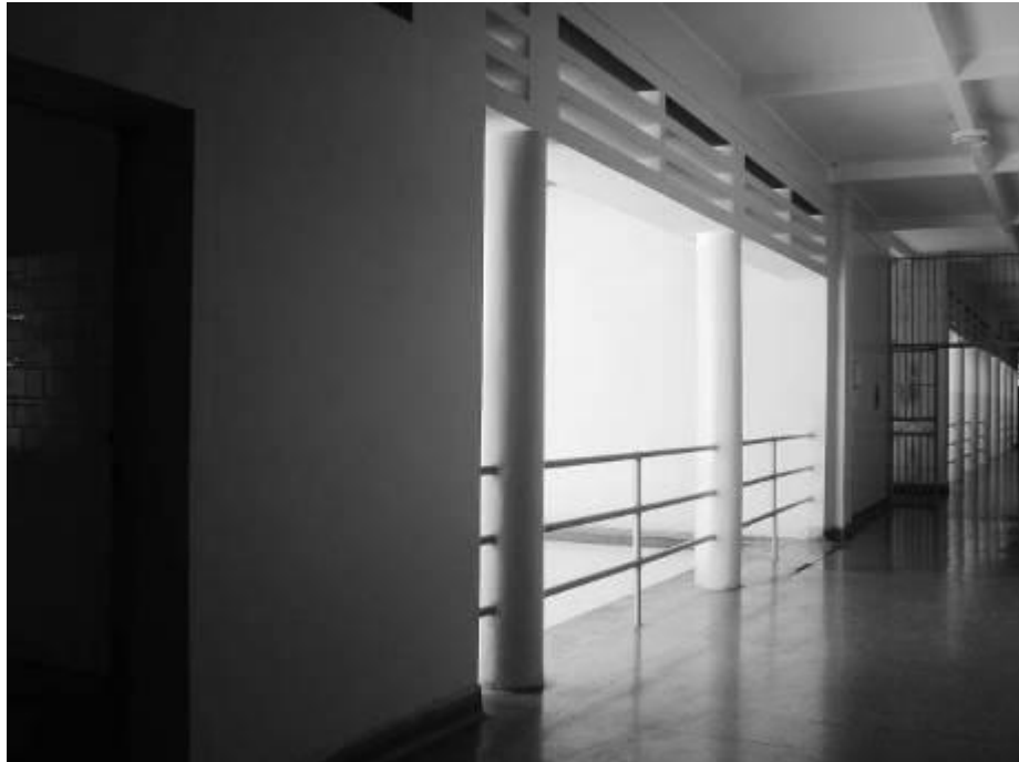
Figura 144. Sanatorio Venezuela. Pasillo interior. Fuente: Fotografía Ana E. Fato O. Mayo, 2010.
