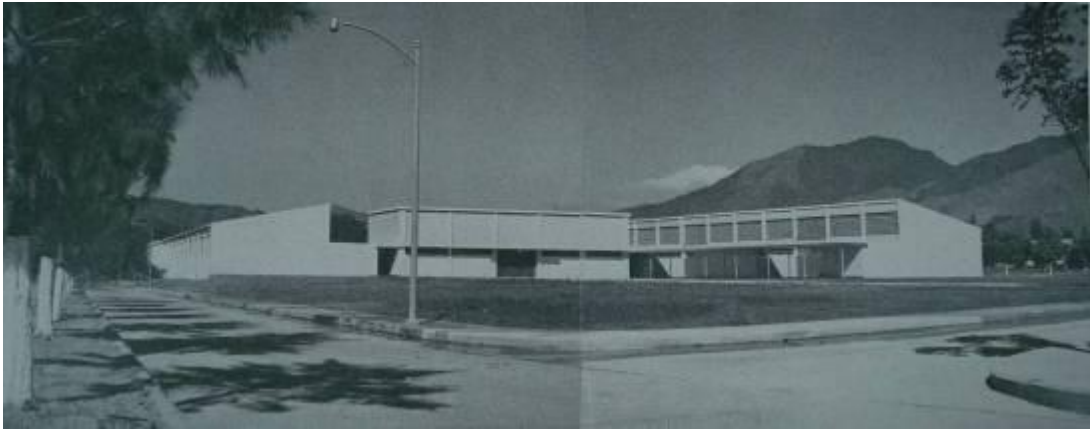
Figura 227. Otra vista de los nuevos pabellones edificados en la Gran Colonia Psiquiátrica de Bárbula. Estado Carabobo. Fuente: VENEZUELA. MINISTERIO DE SANIDAD Y ASISTENCIA SOCIAL. (1957). Memoria , p. 289.
