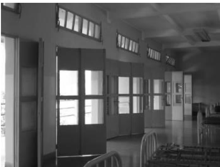
Figura 152. Sanatorio Venezuela. Vista de las habitaciones. Fuente: Fotografía Ana E. Fato O. Mayo, 2010.
