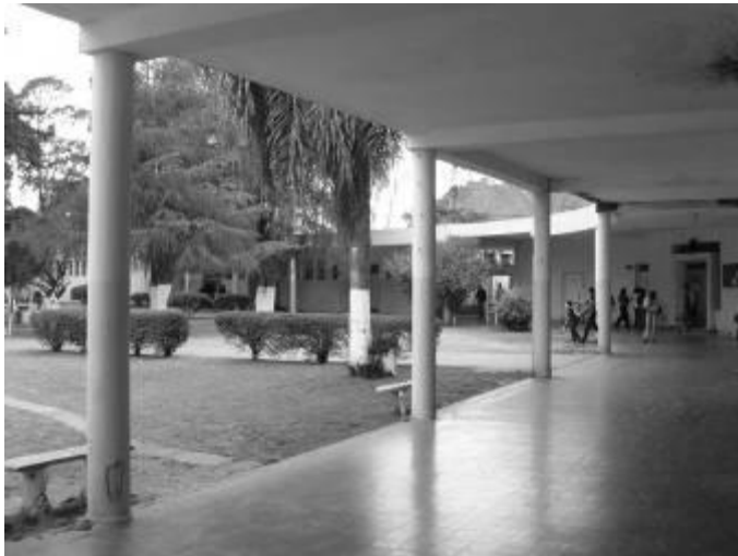
Figura 57. Pasillo Hospital Psiquiátrico Santa Fe, foto Luis Müller. Fuente: Archivo Luis Müller, 2008.
