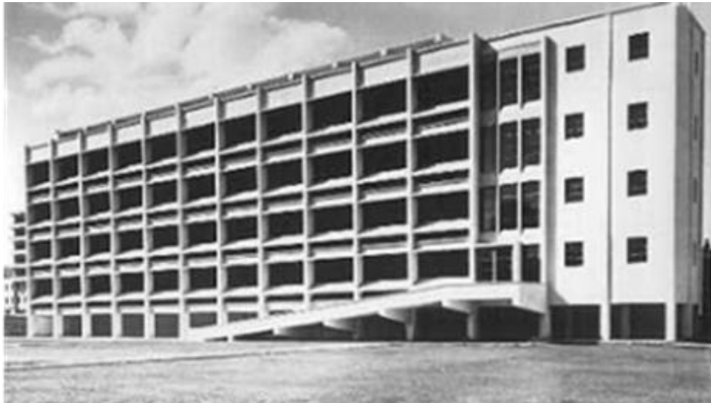
Figura 163. Vista Sanatorio Huipilco. José Villagran 1929. Fuente: BURIAN, Edwards. (1998). Modernidad y Arquitectura en México , p. 77
