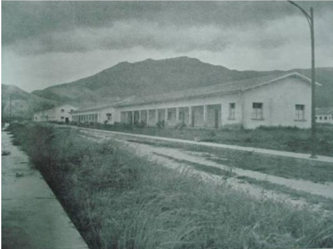
Figura 110. Leprosería Los Caracas. Edificio Administrativo. Fuente: VENEZUELA. MINISTERIO DE OBRAS PÚBLICAS. (1953). Memoria y Cuenta , s/p.
