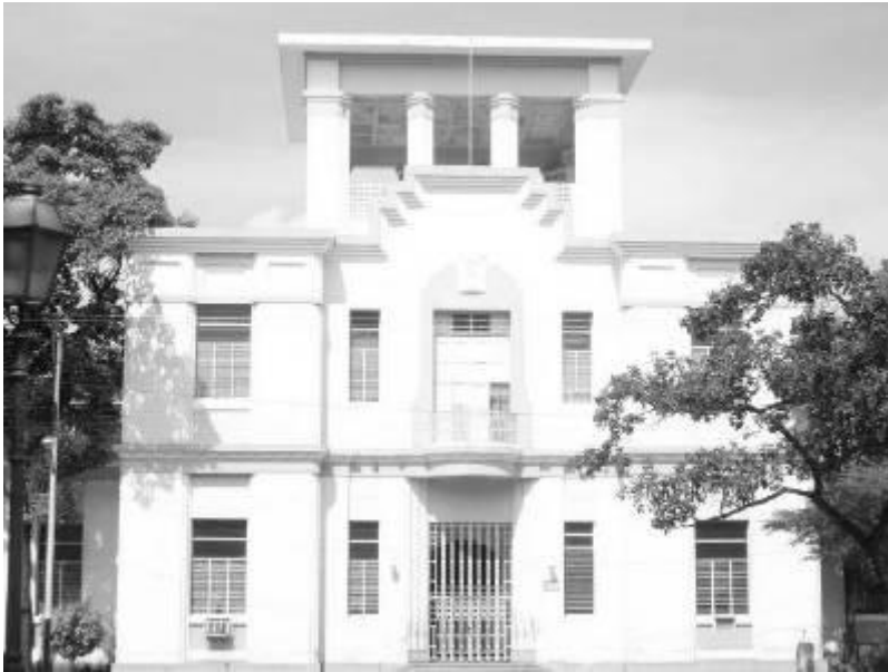
Figura 93. Clínica Maracay. Edificio recién construido. 1930. Fuente: COLMENARES, José Luis. (1989). Carlos Guinand Sandoz , p. 61.
