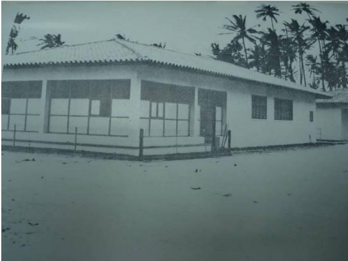
Figura 109. Leprosería Los Caracas. Edificio comedor, cocina, lavandería. Fuente: VENEZUELA. MINISTERIO DE OBRAS PÚBLICAS. (1953). Memo- ria y Cuenta , s/p.
