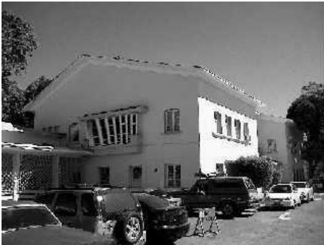
Figura 178. Fachada. Fuente: Fotografía Lic. Luis Weky. Agosto, 2010. Archivos de Ana E. Fato O.
