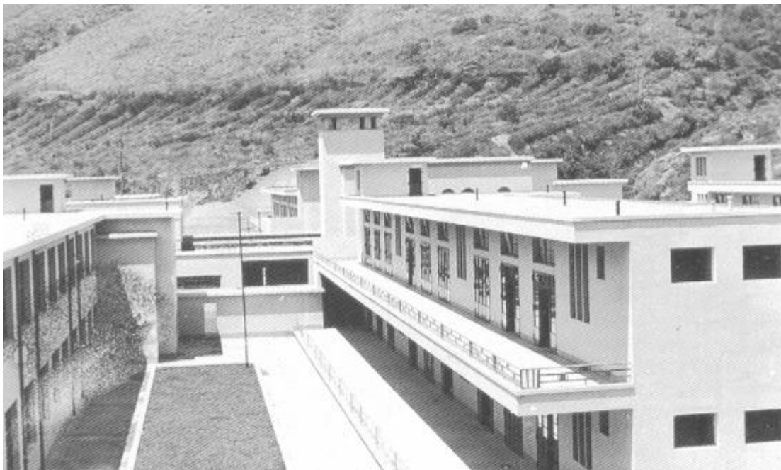
Figura 125. Vista de las alas laterales del conjunto destinadas a las habitaciones. Fuente: FUNDACIÓN GALERÍA DE ARTE NACIONAL-FGAN. (1998). Wallis, Dominguez, Guinand. Arquitectos pioneros de una época , p. 59.
