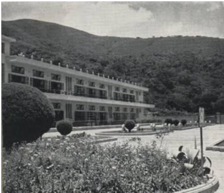
Figura 130. Pabellón de hospitalización, Sanatorio "Simón Bolívar" (c. 1950). Fuente: http://docomomovenezuela.blogspot.com/2011/06/docomomo-iscregisters_7670.html , 03 de marzo, 8:08 am
