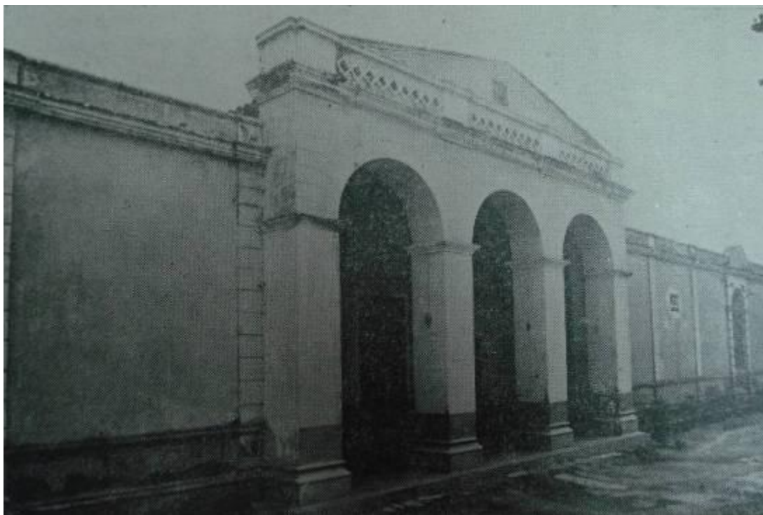
Figura 84. Pórtico del Hospital Militar y del antiguo Asilo de Enajenados de Caracas. Fuente: RICARDO, Álvarez. (1942). La psiquiatría en Venezuela , p. 383.
