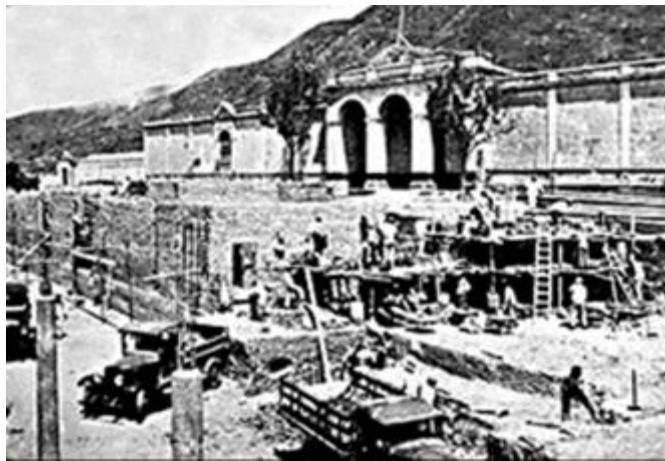
Figura 203. Fotografía durante los trabajos de construcción del Hospital Municipal Psiquiátrico, c. 1934
