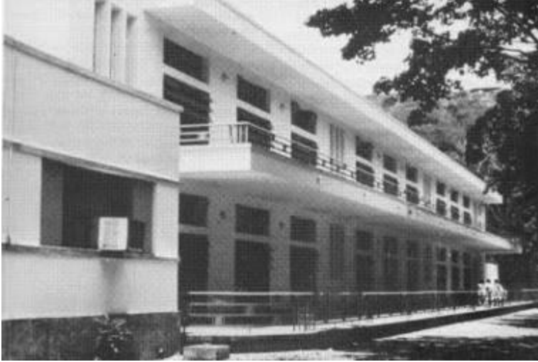
Figura 129. Balcones en voladizo; sirven de terraza de asoleamiento para pacientes. Fuente: COLMENARES, José Luis. (1989). Carlos Guinand Sandoz , p. 127.
