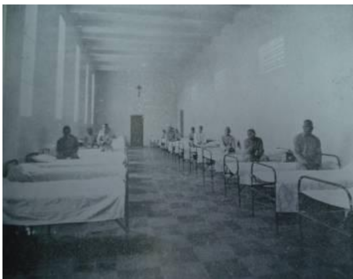
Figura 208. Aspecto de una de las salas del Hospital Municipal Psiquiátrico. Fuente: Boletín de los Hospitales Civiles del Distrito Federal . (1938), No. 12, p. 477.
