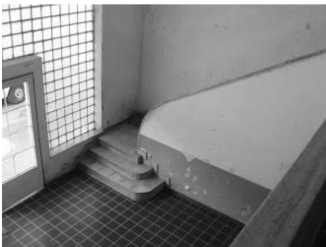
Figura 63. Edificio de consultorios y administración Colonia de Oliveros, foto Luis Müller. Fuente: Archivo Luis Müller, 2008.
