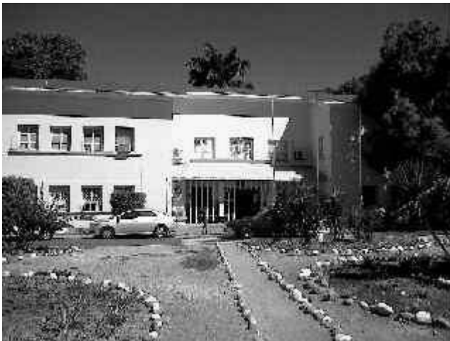
Figura 177. Fachada. Fuente: Fotografía Lic. Luis Weky. Agosto, 2010. Archivos de Ana E. Fato O.
