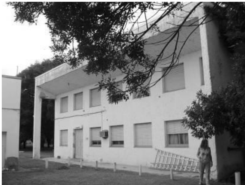
Figura 53. Pabellón tipo, fachada principal Leprosario en Recreo. Fuente: Fotografía Ana E. Fato, abril, 2009.
