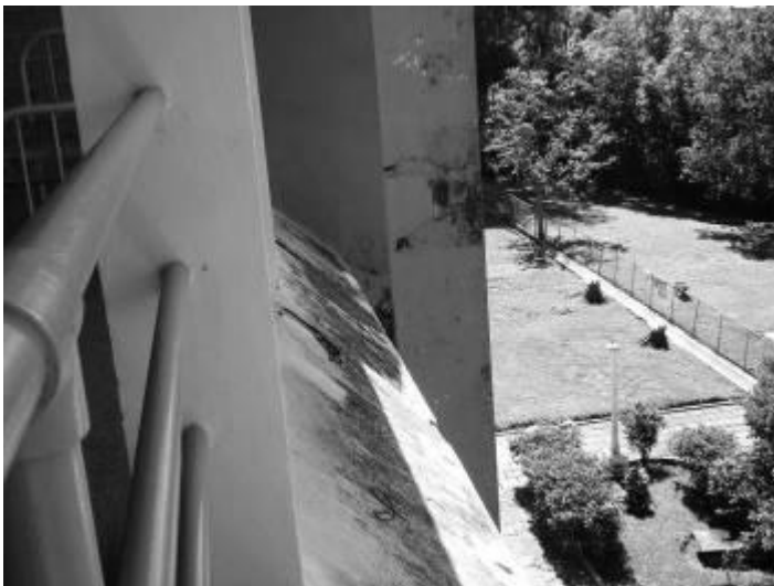
Figura 161. Vista de la losa visera corrida. Fuente: Fotografía Ana E. Fato O. Mayo, 2010.
