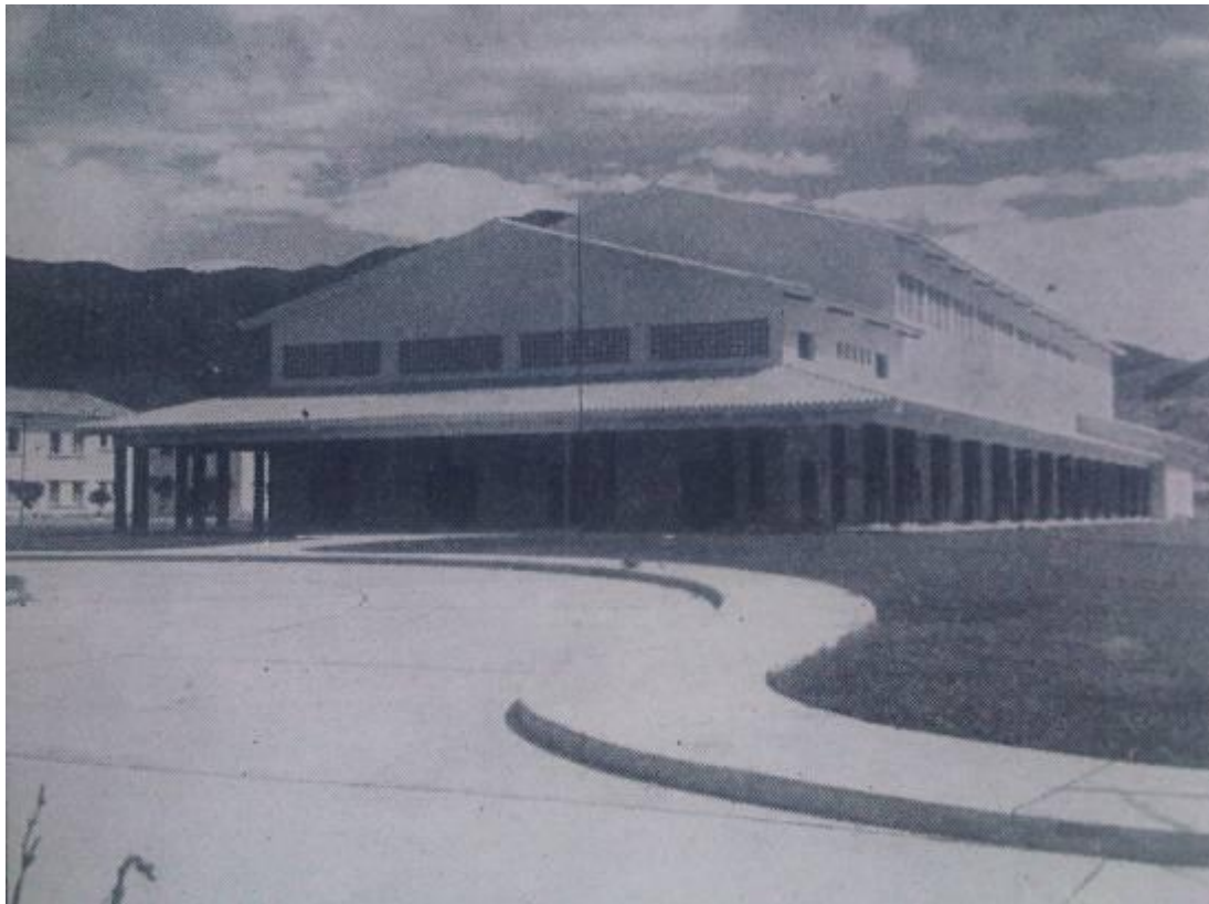
Figura 239. Teatro de la Colonia Psiquiátrica de Bárbula. Fuente: Realizaciones durante el segundo gobierno del coronel Marcos Pérez Jiménez. 2 de diciembre de 1953 – 19 de abril de 1955, p. 58.
