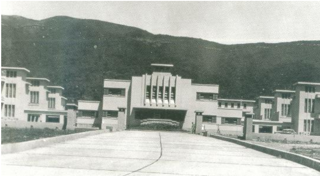
Figura 123. Sanatorio Antituberculoso Simón Bolívar (1936-1939). Fuente: FUNDACIÓN GALERÍA DE ARTE NACIONAL-FGAN. (1998). Wallis, Domínguez, Guinand. Arquitectos pioneros de una época , p. 60.
