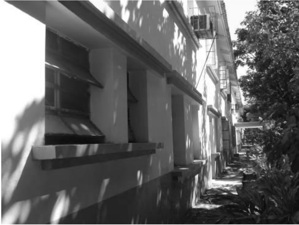
Figura 245. Colonia Psiquiátrica de Bárbula. Edificio Administrativo. Fuente: Fotografía Ana E. Fato O. Agosto, 2011.
