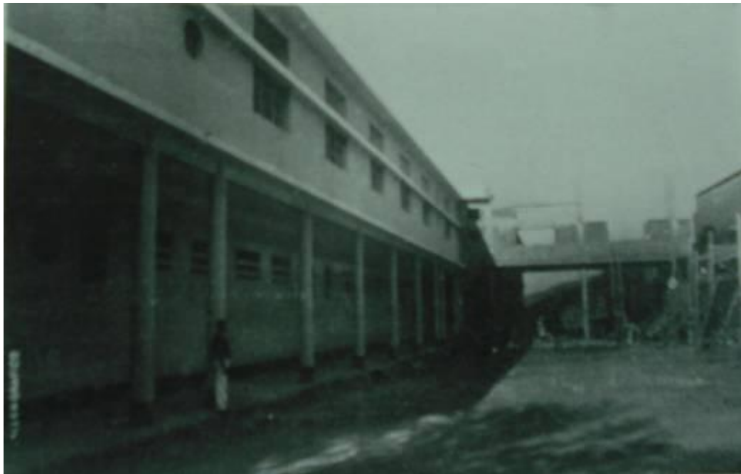
Figura 213. Hospital Psiquiátrico Municipal. Fuente: FUENTE: VENEZUELA. MINISTERIO DE OBRAS PÚBLICAS. (1938). Memoria , tomo 1, p. 6-D
