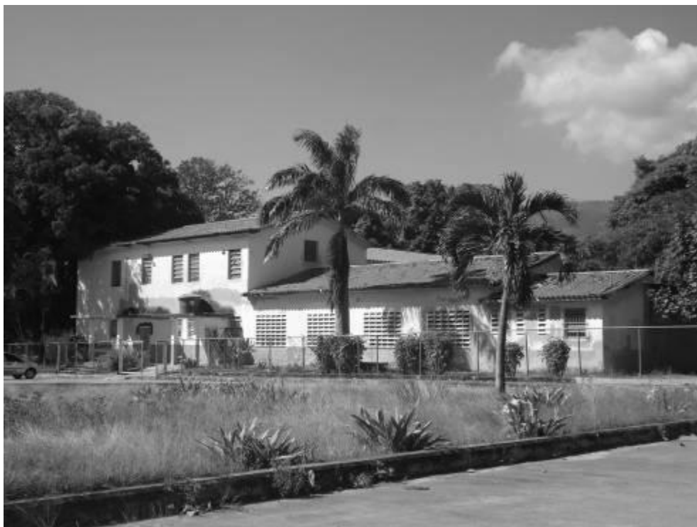
Figura 230. Pabellón de la Colonia Psiquiátrica de Bárbula. Fuente: Fotografía Ana E. Fato O. Agosto, 2011.
