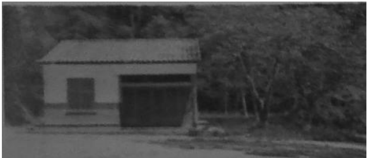
Figura 100. Leprosiería Los Caracas. Vivienda unifamiliar aislada. Fuente: Fuente: SANZ, Pedro (1983). "La ciudad Moderna. Los Caracas ciudad vacacional. Los Caracas ciudad hospital". Punto. No. 65, p. 69.
