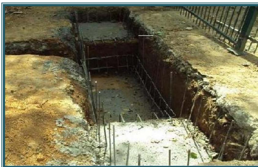
**Fotografía n° 56.** Construcción de la tanquilla de drenaje pluvial en el sector 1 de Los Cedros (vereda central). Tomada por el Consejo Comunal Los Cedros Sector 1 Mayo 2009.
