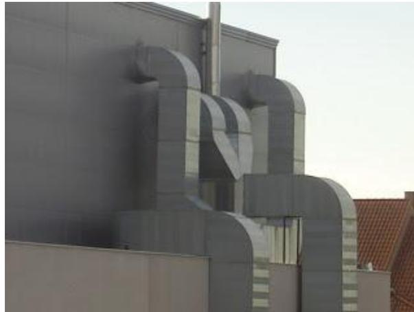
Figura 4. 4 “Ductos de acero galvanizado”
