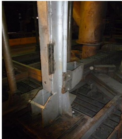
Equipo instalado en el Horno de Reducción
