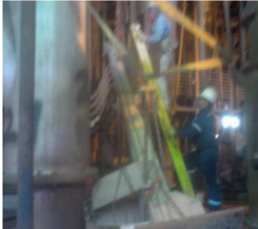
Instalación del equipo en el horno de reducción
