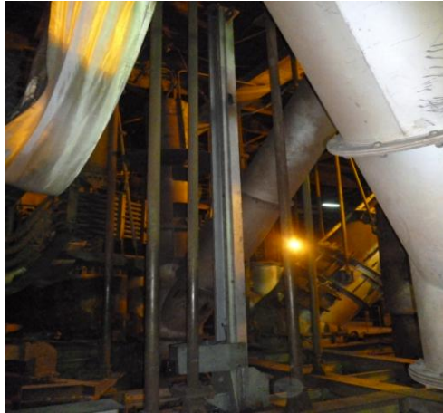
Equipo instalado en el Horno de Reducción
