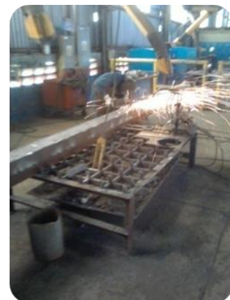
Fig. 5.20. Esmerilando los Cordones de Soldadura
