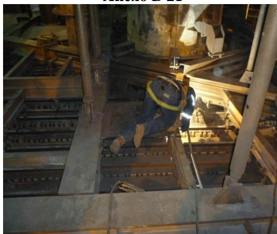
Soldadura de la Base del equipo en el Horno de Reducción
