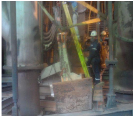
Instalación del equipo en el horno de reducción
