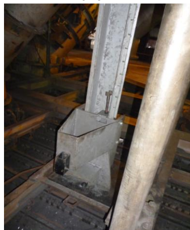
Equipo instalado en el Horno de Reducción
