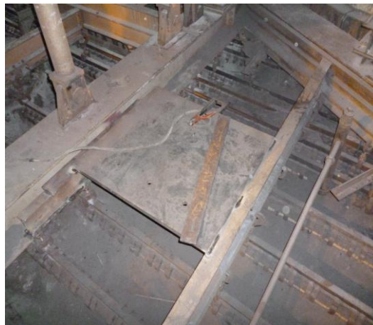
Instalación de la base en el Horno de Reducción
