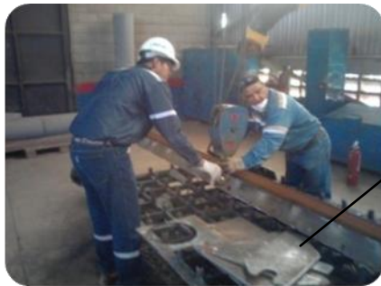
Fig. 5.23. Polipasto de Grúa 5Ton
