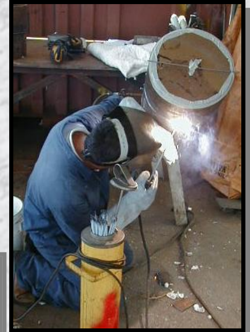
Soldadura de Relleno SMAW
