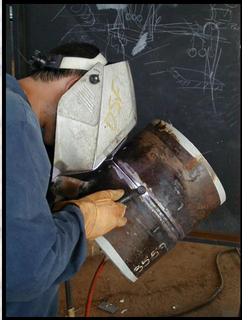
Soldadura de Raíz GTAW
