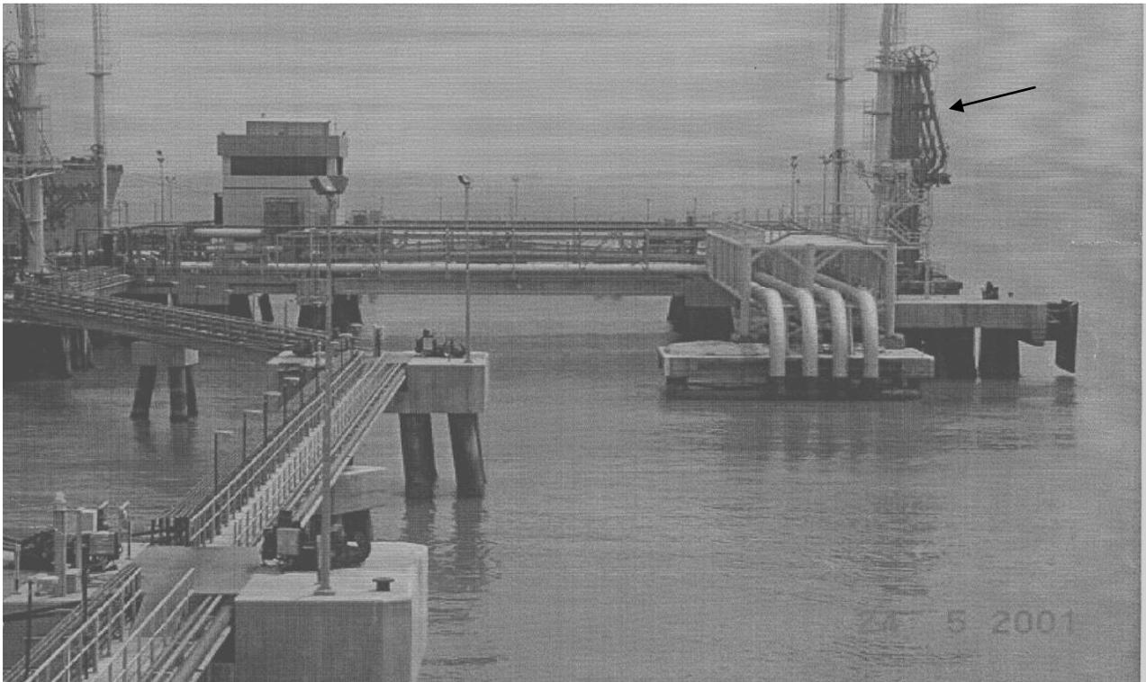
**Fotografía IV.5.1.K Vista de la Plataforma de Embarque Norte, en donde se puede apreciar cuatro de los brazos de carga retraídos.**
