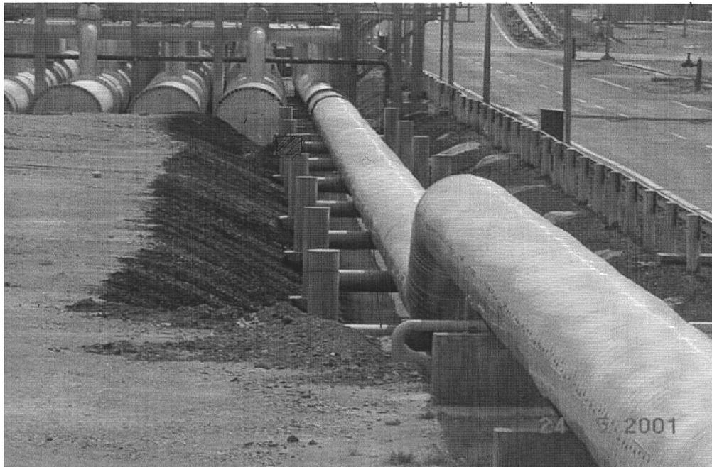
**Fotografía IV.5.1.A Vista de las líneas de 60" asociadas a los cabezales de succión de las bombas de embarque del TAEJ-N**
