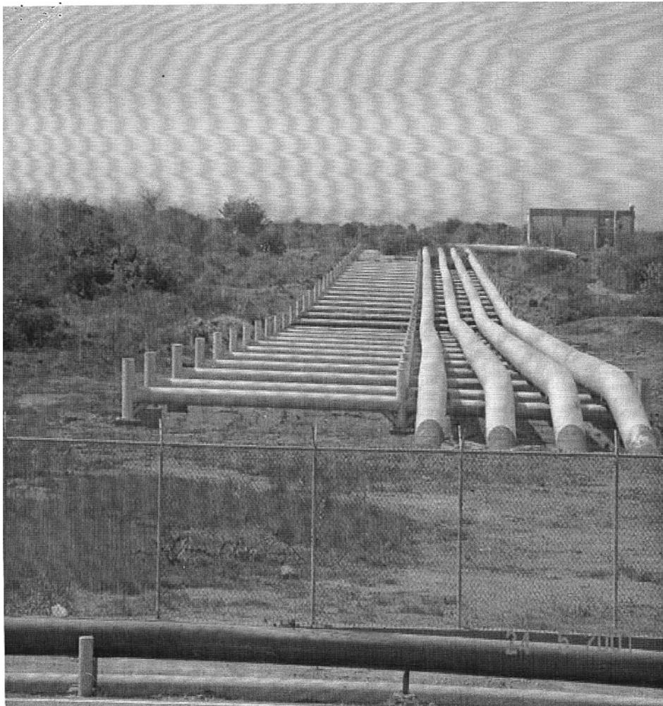
**Fotografía IV.5.1.J Vista de los dos lazos de descarga de crudo de 36” hacia la Plataforma de Embarque Norte mar adentro.**
