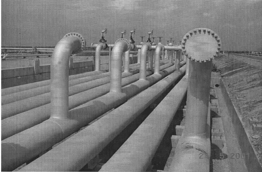
**Fotografía IV.5.1.G Corredor de las líneas de 36” con conexiones para futuros cabezales de descarga**
